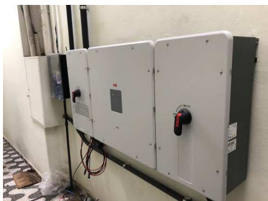
(e) Inversor ABB 50 kW instalado.
