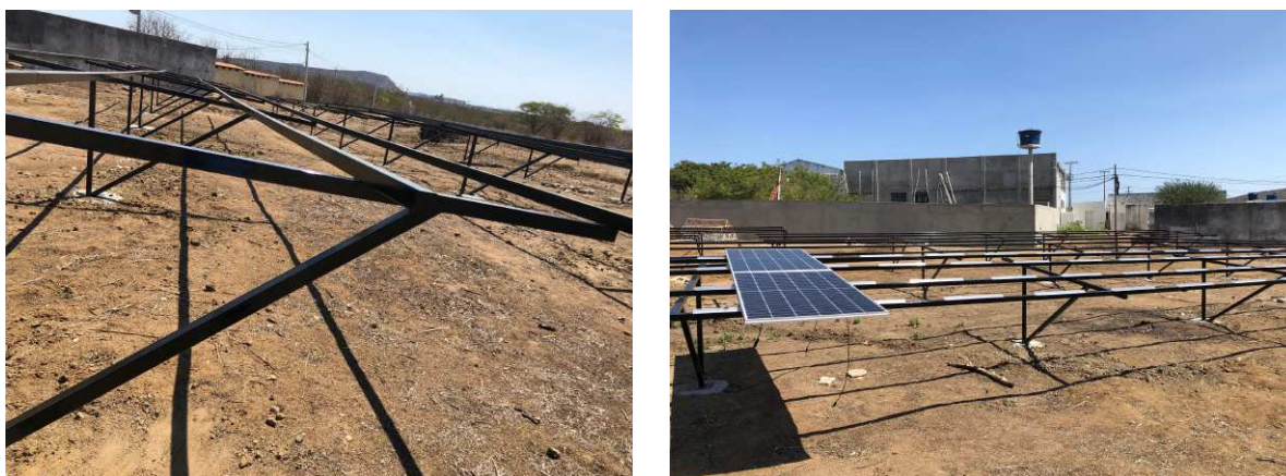
Figura 15 – Estrutura de solo montada.
