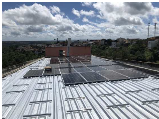
(c) Instalação das estruturas de fixação.
