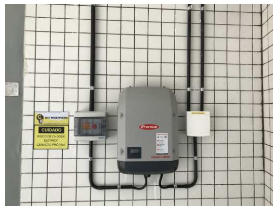
(d) Inversor Fronius 25 kW instalado.
