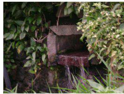
(d) Esgoto despejando detritos na Lagoa de Cuité Fonte: Sales (2010).
