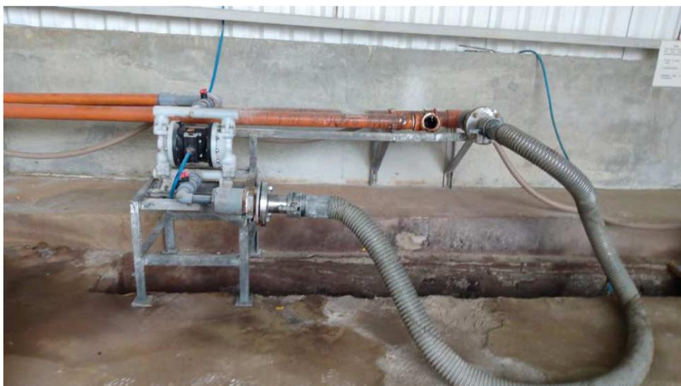
Figura 27 – Sistema de Descarrego de Ácido Sulfúrico por Bomba Pneumática. (Fonte: Própria Autora)
