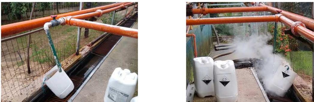
Figura 24 – (a) Suspiro da Tubulação de descarrego de ácido bruto (b) Derramamento de ácido bruto sem contenção adequada.
