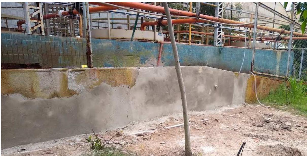
Figura 28 – Mureta de contenção com nova camada de concreto. (Fonte: Própria Autora)
