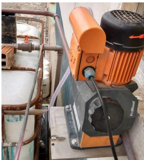
Figura 42 – Bomba dosadora de soda temporizada. (Fonte: Própria Autora)
