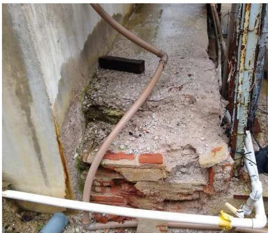
Figura 26 – Tubulação de drenagem de ácido sulfúrico deformada. (Fonte: Própria Autora)
