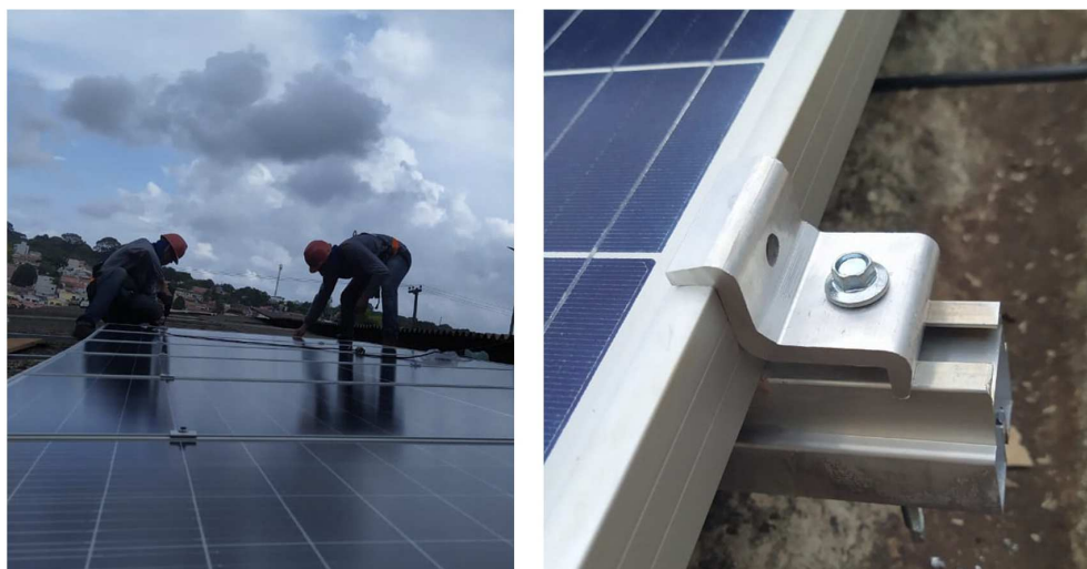
Figura 15 – Instalação do sistema: (a) fixação dos conectores e (b) detalhe do conector terminal ou end clamp .
