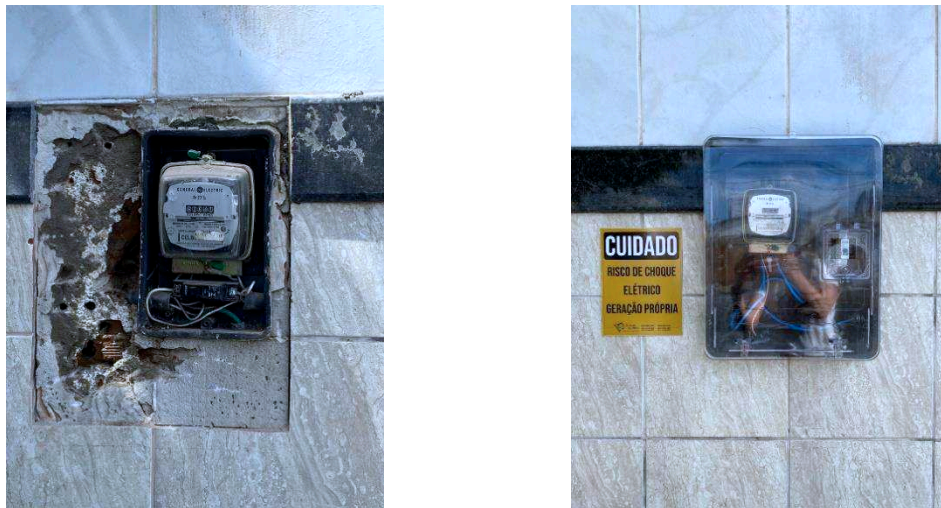
Figura 22 – Troca da caixa monofásica para trifásica.
