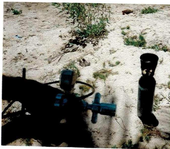
**Figura III.4 - Válvula de alimentação com proteção metálica rompida.**
