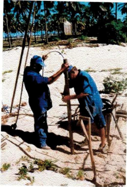
**Figura III.5 - Início da cravação do sistema sonda – haste.**
