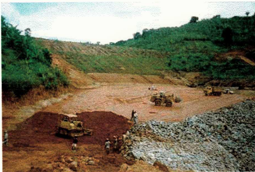
Figura 5 – Ampliação da Barragem de Tauá.
