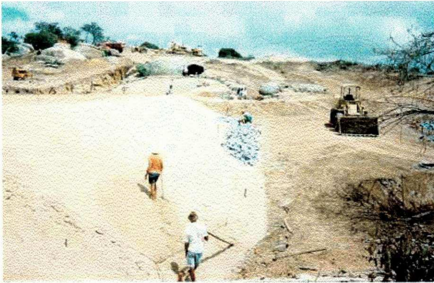
Figura 4 – Aspecto de construção da Barragem de Milhã.
