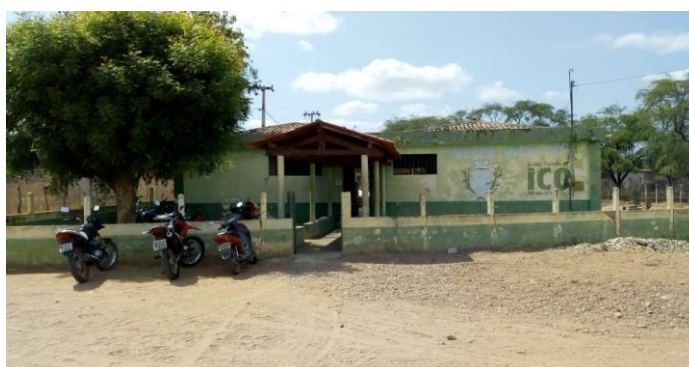
FIGURA 2: Fachada da Escola Municipal Francisco Assis Marcolino
