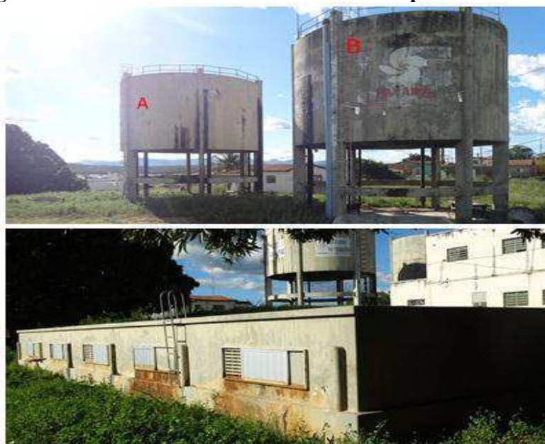
Figura 13 – Reservatórios da ETA do município de Pombal – PB
