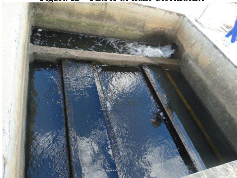
Figura 12 – Filtros de fluxo descendente
