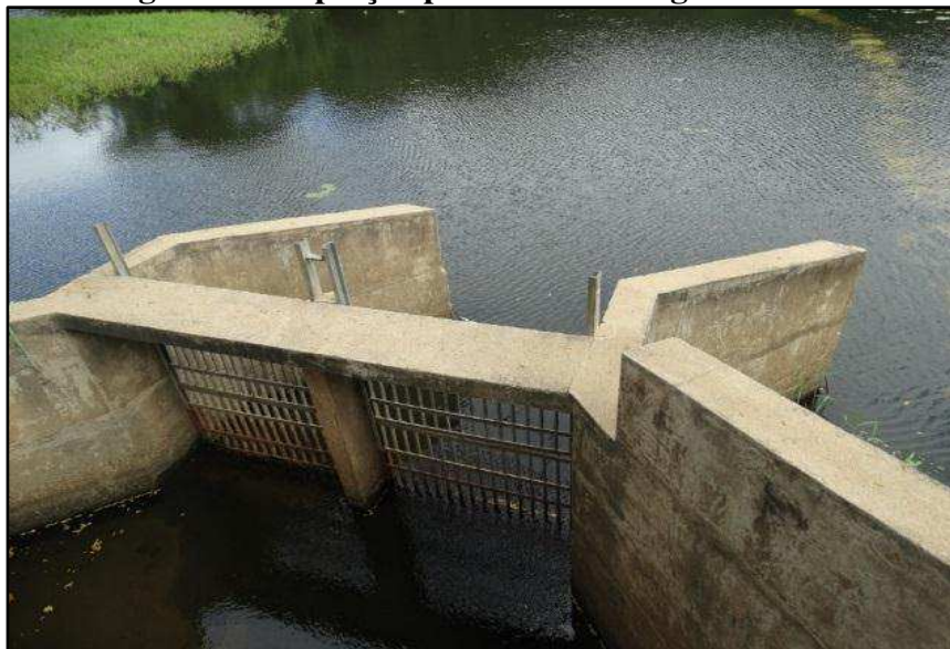
Figura 7 – Captação por tomada de água indireta
