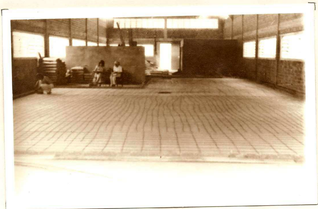
Modêlo Tridimensional - Armadura da Laje
