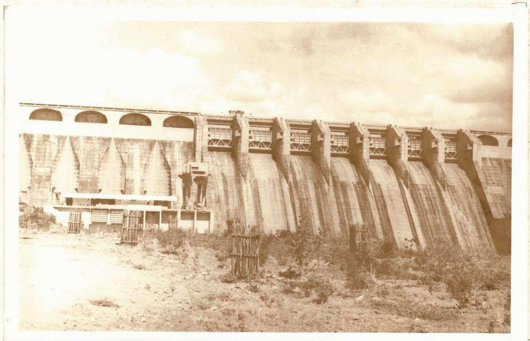
Barragem da Pedra - Vertedores e Usina
