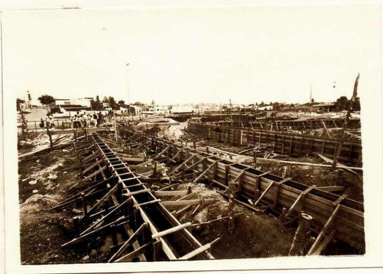
Cintas do Prédio
