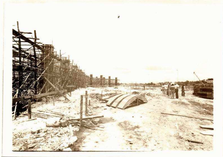
Vista de Frente do Prédio.
