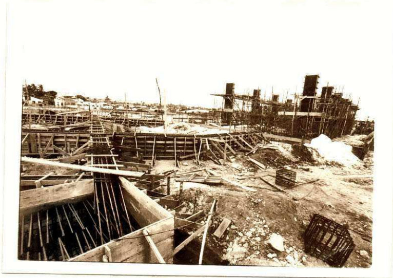
Visão geral das cintas do Auditorium e Pilares do Prédio.
