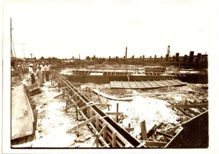
Cintas, pilares e blocos tanto do Auditorium como do Prédio.
