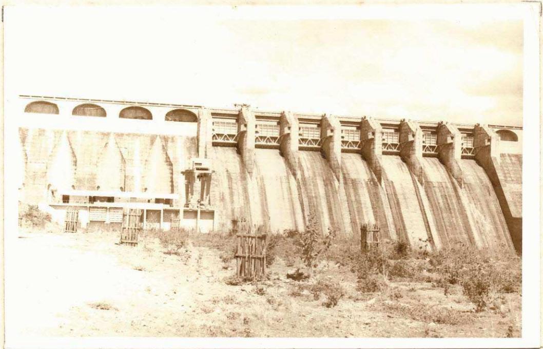
Barragem da Pedra - Vertedores e Usina
