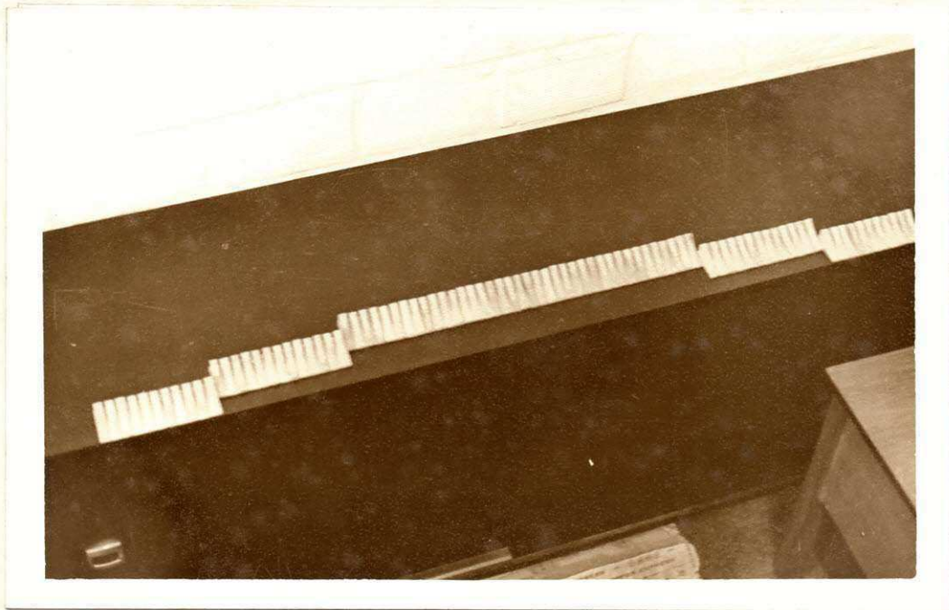
Modelo Tridimensional - Dentes da Soleira de Dissipação
