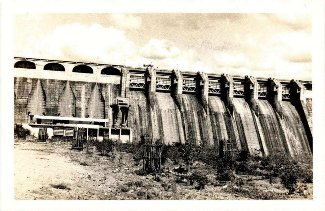
Barragem da Pedra - Vertedores e Usina
