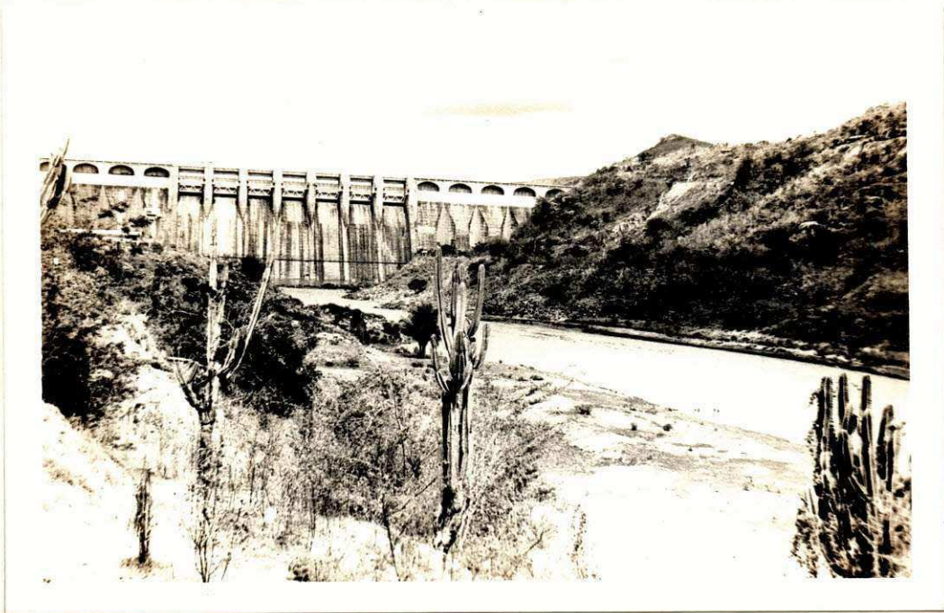
Barragem da Pedra - Vista de Jusante
