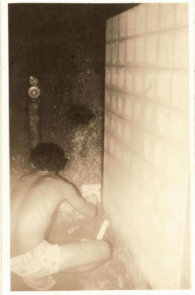
O azulejista aplica uma camada de pasta de cimento e cal e colocava os azulejos, apertando-os de encontro a parede. O excesso de pasta que ressaltava pelas bordas do azulejo, era retirado antes que esta secasse.
