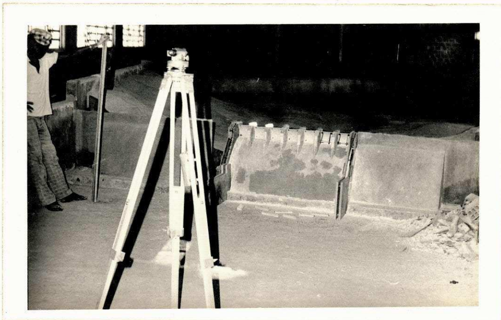
FOTO 6 - IMPLANTAÇÃO DE PILARES E COMPORTAS
