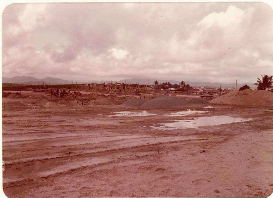
3.2 - VISTA DA FIXAÇÃO DOS PREMOLDADOS NA FUNDAÇÕES
