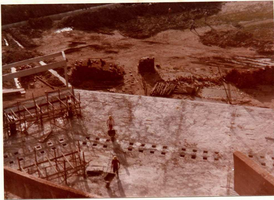
VISTA DA CONCRETAGEM DA LAGE DE FORRO DO BLOCO COMUNITÁRIO.
