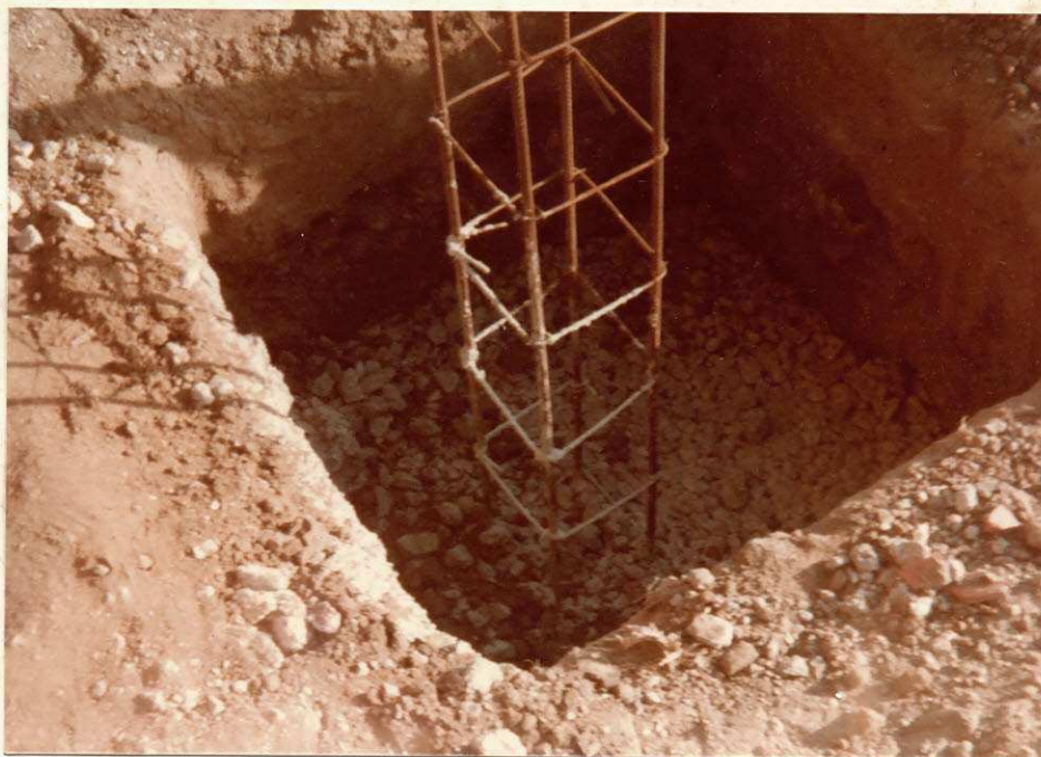
VISTA DE UMA FUNDAÇÃO.
