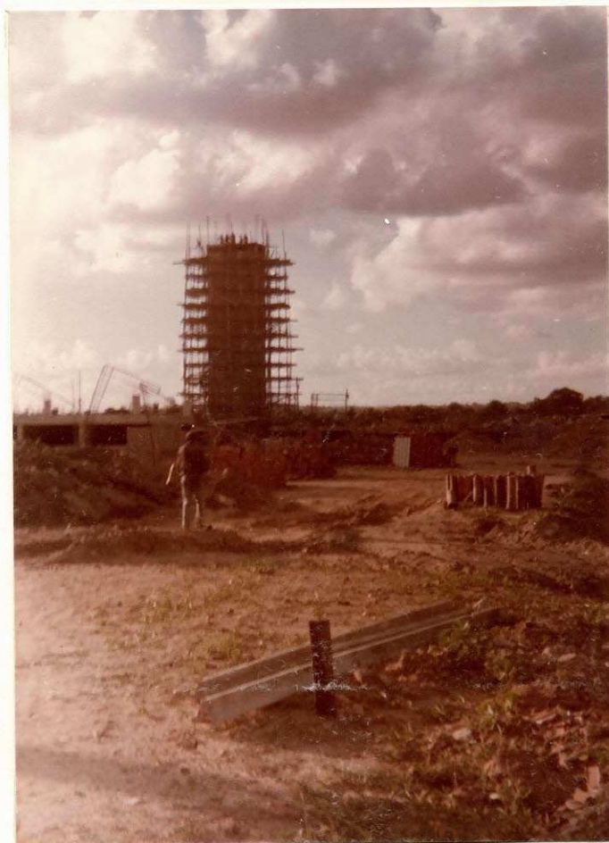
VISTA DA CAIXA D'ÁGUA .
