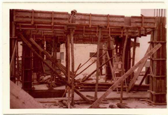
COLOCAÇÃO DAS FORMAS DAS VIGAS
