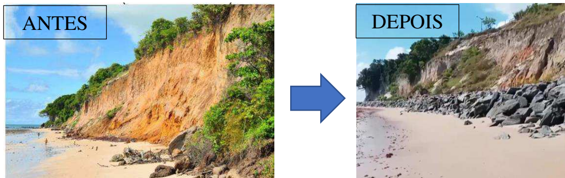
Figura 11: Registro comparativo entre o antes e depois da intervenção das obras com as rochas no sopé da barreira, 2020-2021.
