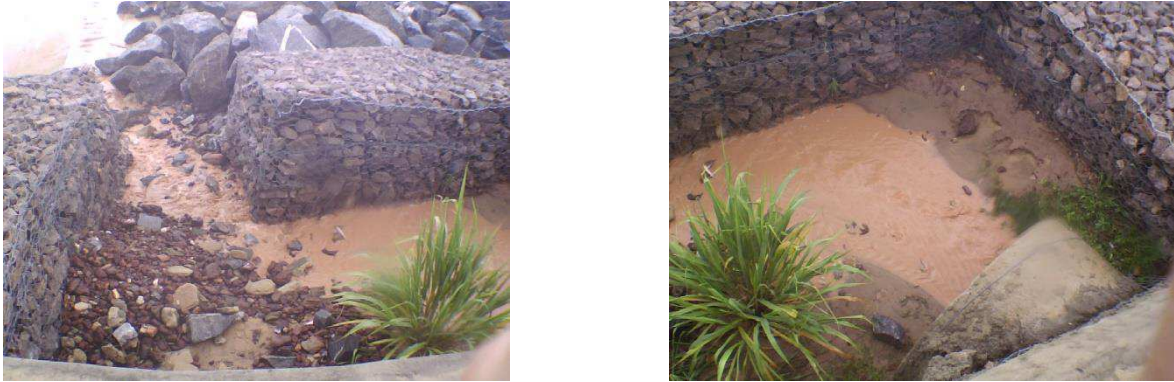
Figura 13: Registro da deposição de águas pluviais advindas da porção superior da barreira do Cabo Branco, obra realizada durante a primeira fase do projeto.
