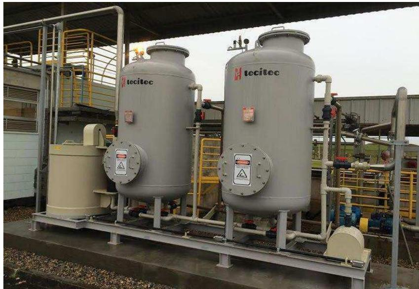
**Figura 2: Modelo de filtro multimeio para tratamento de efluentes.**
