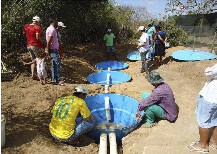
**Figura 3: Modelo de fossas biodigestoras para tratamento de efluentes.**
