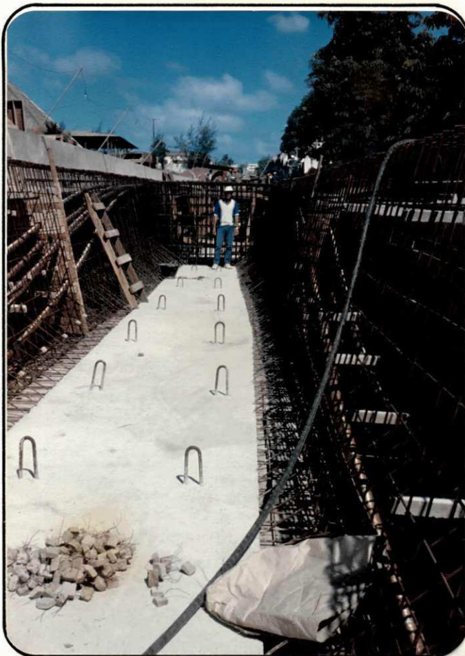
FOTO 16 - Vista da viga da pista direita com a parte inferior já concretada e detalhe das bainhas onde ficam os cabos de proteção.
