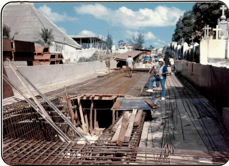
FOTO 17 - Armação da laje da Pista Direita com armação da viga já concluído.
