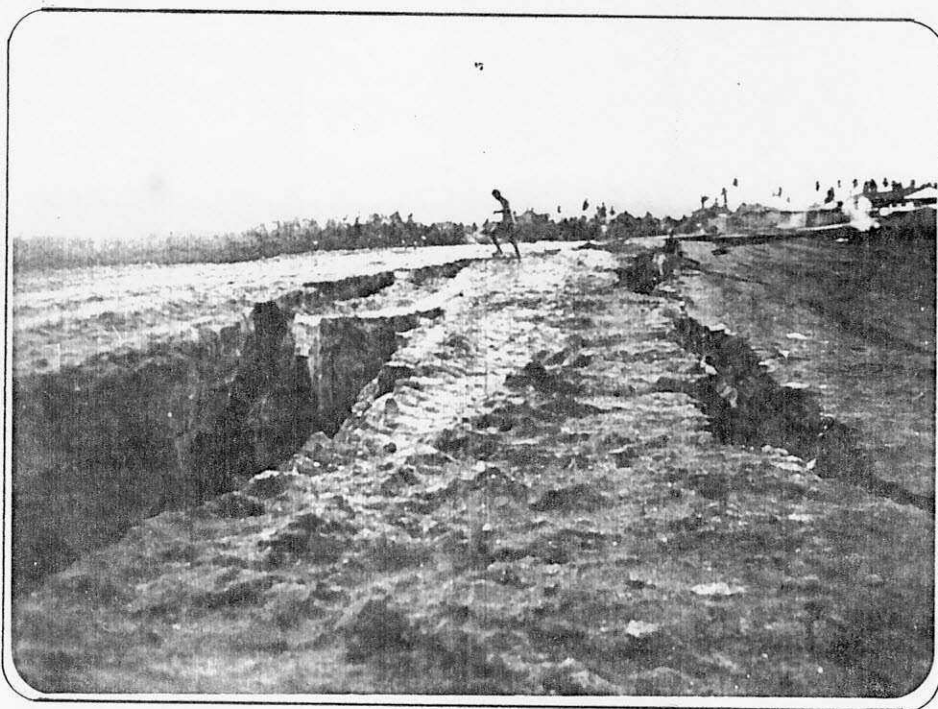
FOTO 10 - Vista do aterro Avenida Nova Liberdade, detalhando as ruturas ocorridas.
