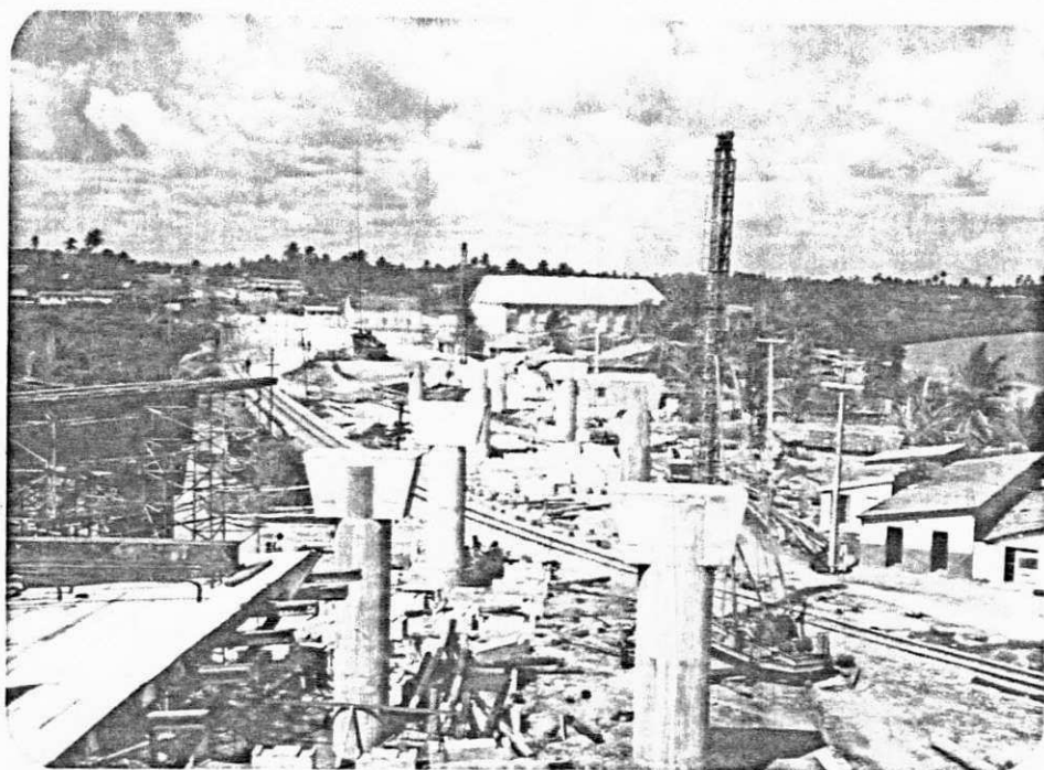
Foto 16 - Panorâmica de parte do percurso por onde passará o viaduto, destacando-se a presença dos blocos de apoio do escoramento, os pilares de sustentação e o trecho da linha férrea que passará por baixo do viaduto.
