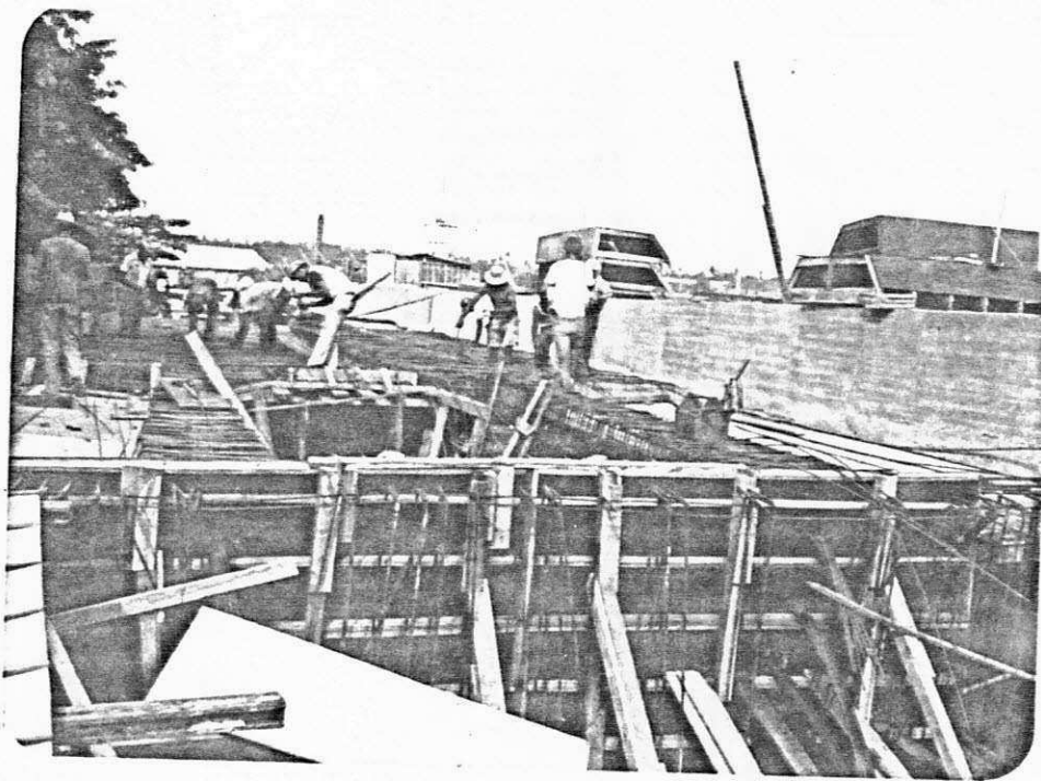
Foto 24 - Colocação da ferragem da laje superior do trecho I - Pista Direita.
