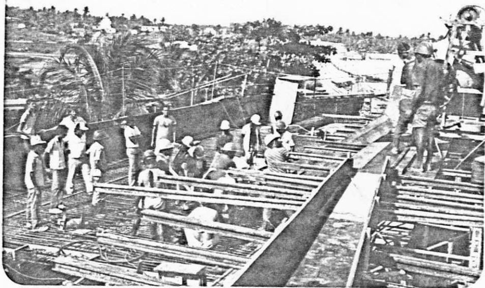
Foto 26 - Concretagem de parte do trecho I - Pista Direita.
