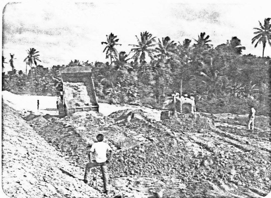
Foto 12 - Colocação de uma camada protetora de quarenta centímetros ao lado da pista esquerda.
