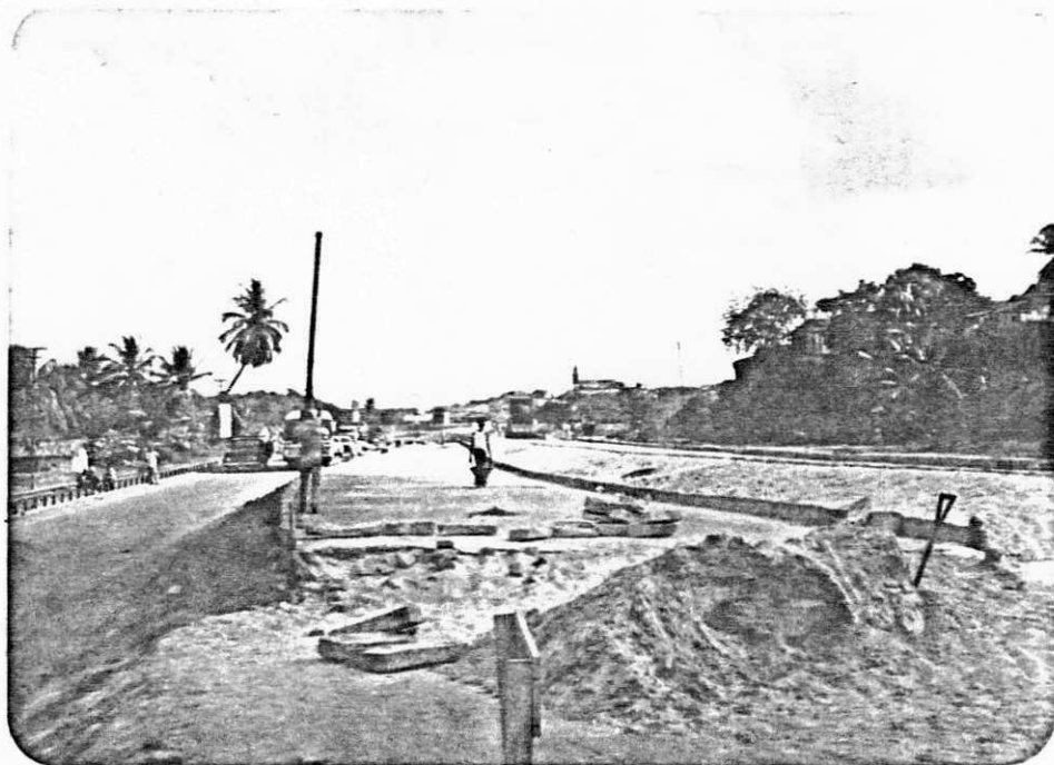
Foto 3 - Vista do calçamento compreendido entre as Ruas Idaleto e da República, observando-se a areia e a pedra calcárea usadas no macadame.
