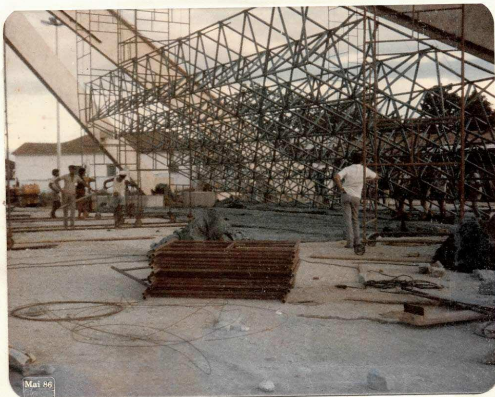
Treliças Tridimensionais sendo suspensas
