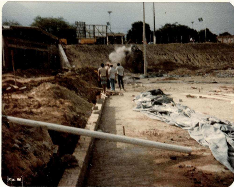
Explosão de rochas existentes ; ao lado esquerdo os banheiros, a vista a tesoura metálica.
