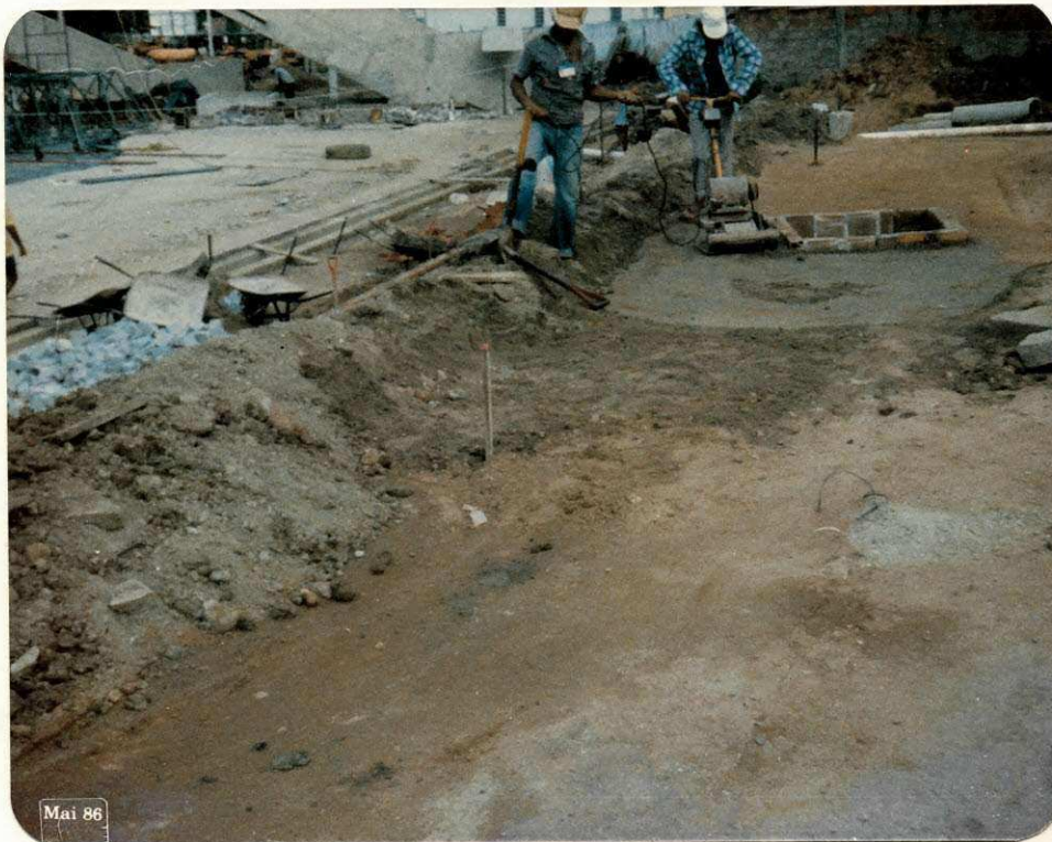
Compactação mecânica (sapinho)
