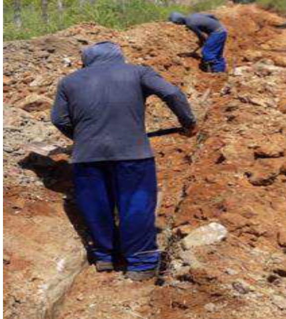
Figura 8. Trabalhadores removendo solo com pedregulhos
