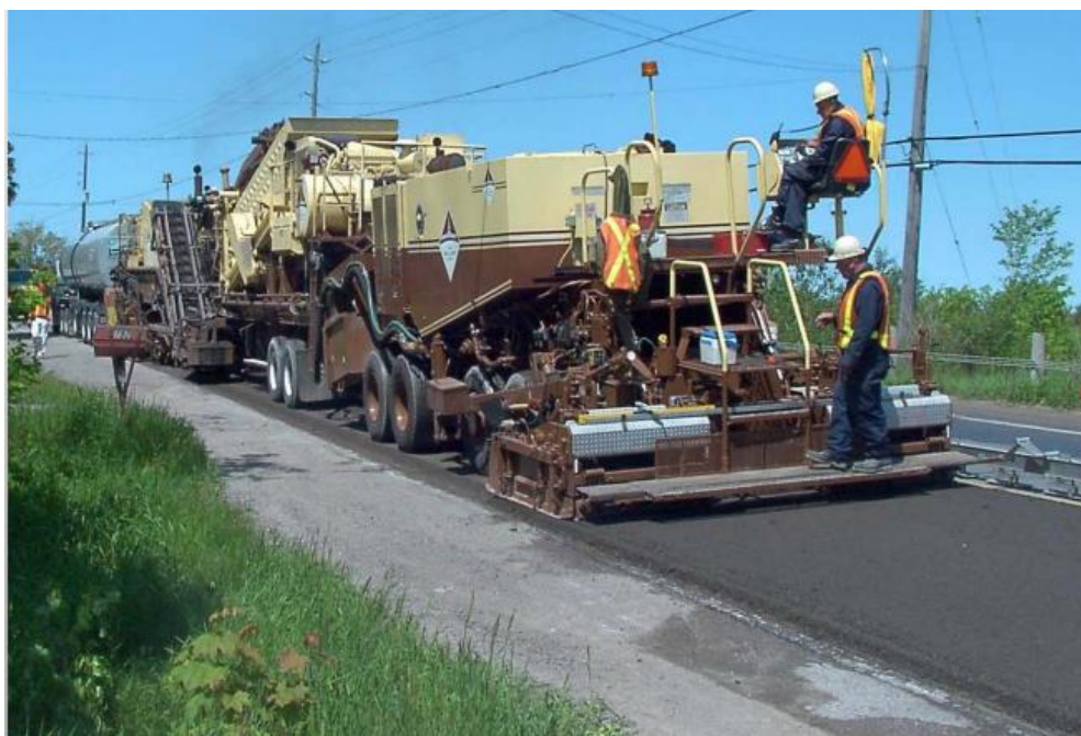
Figura 3 - Unidade de reciclagem a frio in situ em operação
