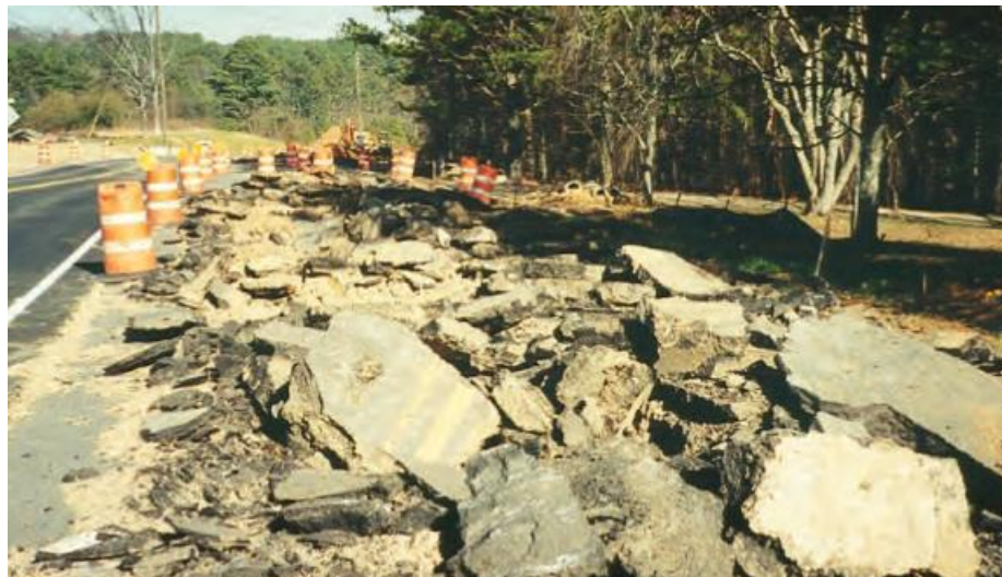
Figura 4 - Remoção de pavimento em total profundidade
