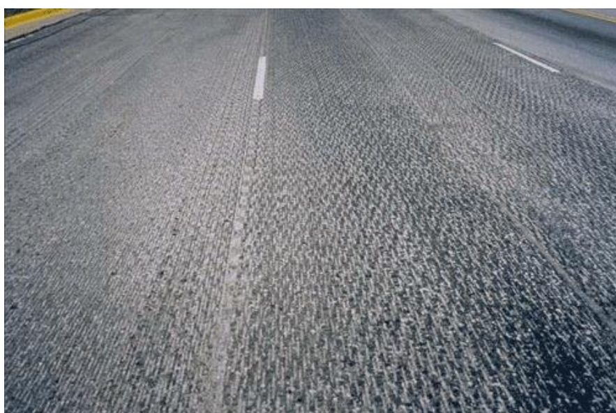
Figura 2 - Superfície de um pavimento após procedimento de fresagem
