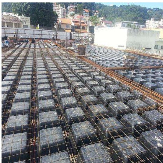
Figura 5 – Laje nervurada moldada in loco sem material de enchimento, utilizando fôrmas de polipropileno
