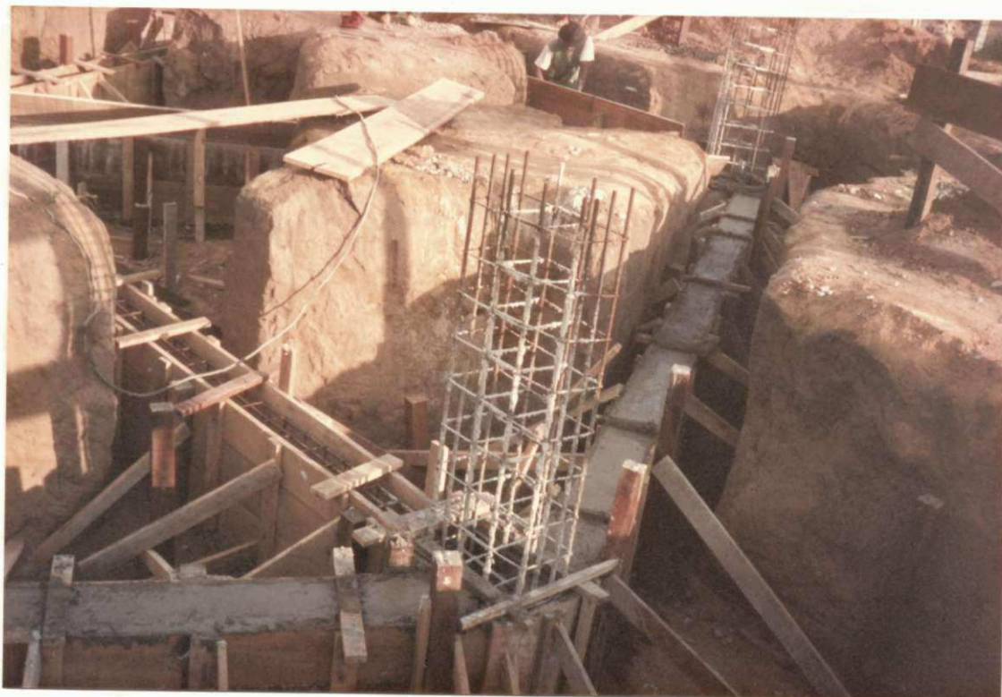
5. Reservatório Elevado de 500 m 3 - Araruna
