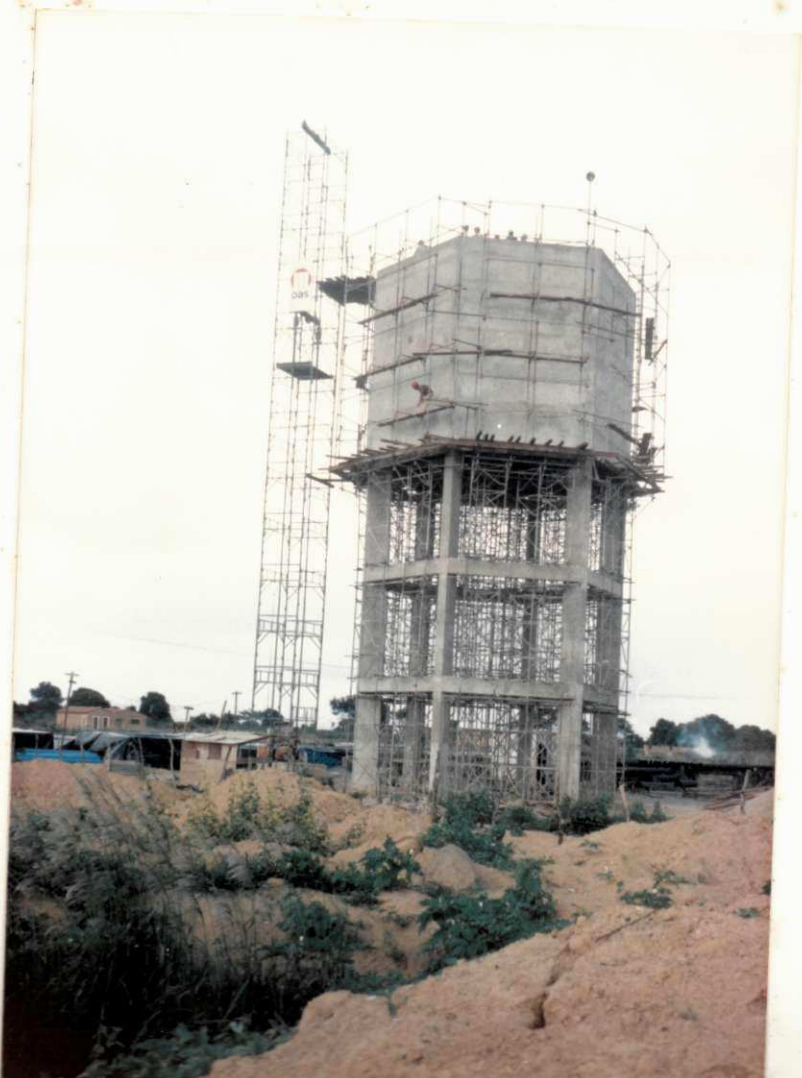
14. Reservatório Elevado de 300 \text{ m}^3 - Cuité
