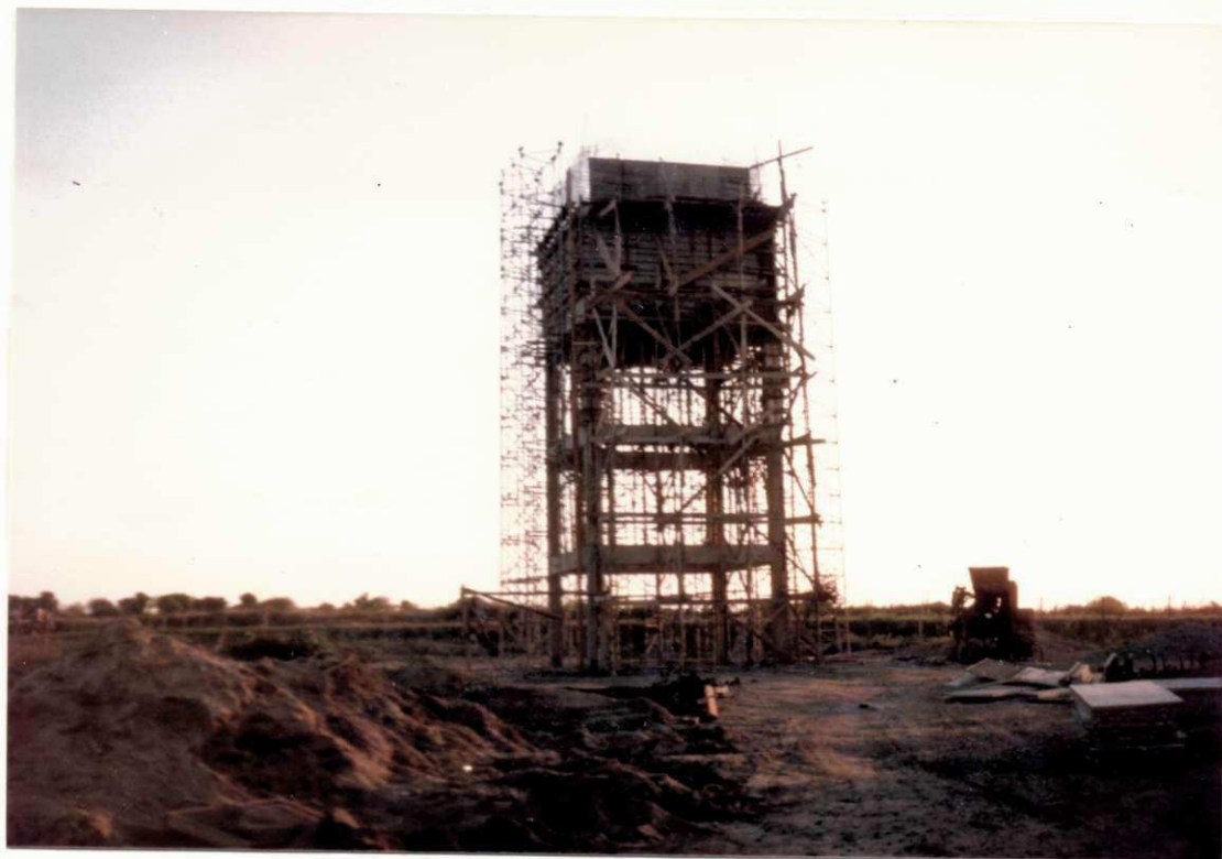
19. Reservatório Elevado de 150 \text{ m}^3 - Pocinhos
