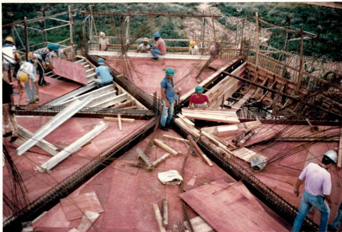
7. Reservatório Elevado de 500 m 3 - Araruna
