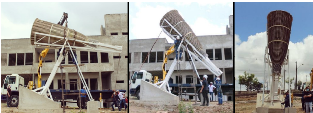
Figura 4 – Imagens da instalação do Uirapuru na UFCG. Laboratório observacional constituído por uma das cornetas (outrigger) do BINGO. Fonte: Colaboração BINGO.
