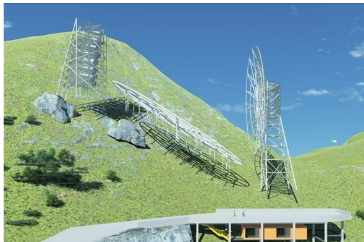
Figura 1 – Desenho ilustrativo do radiotelescópio BINGO com o sistema óptico do tipo Crossed-Dracone. Fonte: Colaboração BINGO, [12].
