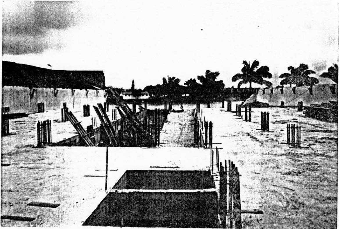
FOTO DA CONCLUSÃO DO PAVIMENTO TÉRREO - PARTE B
