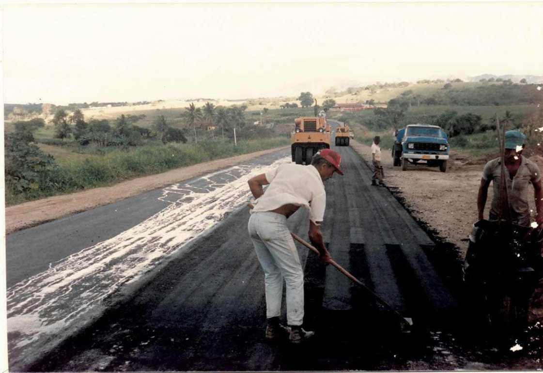
Rolagem da camada de Binder usando rolo pneumático
