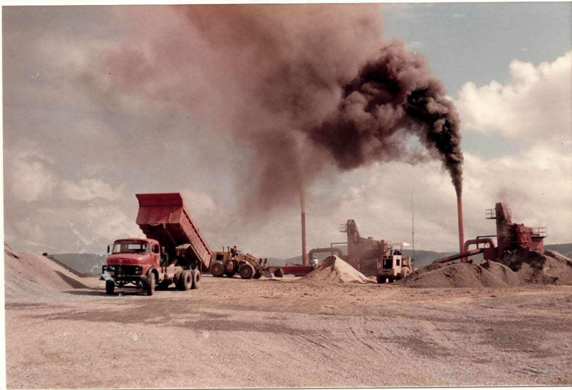
Usinas de asfalto em funcionamento
