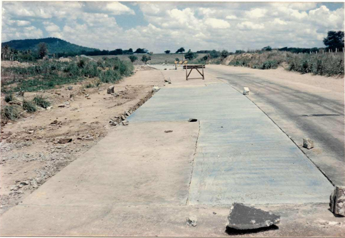
Detalhe de um trecho onde houve substituição de placas
