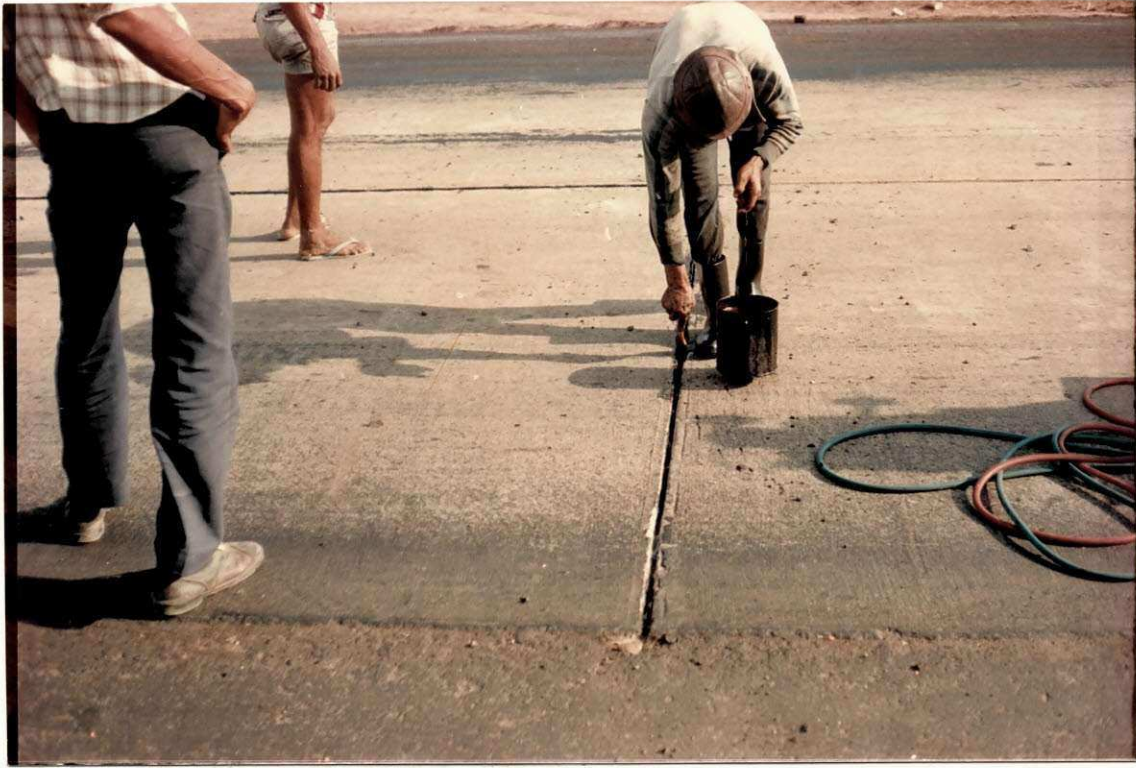
Aplicação de emulsão para o preenchimento das juntas
