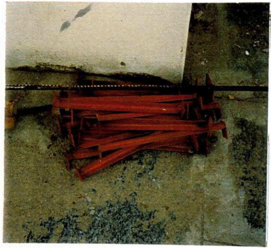
PEÇAS PARA TRELIÇAS DAS VIGAS
