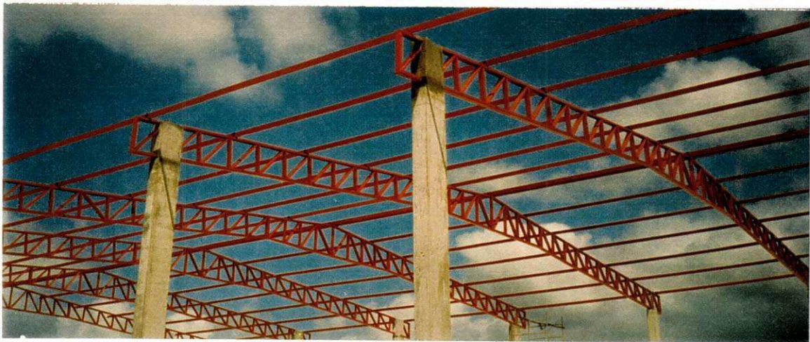
ESTRUTURA PRONTA PARA COBERTA
