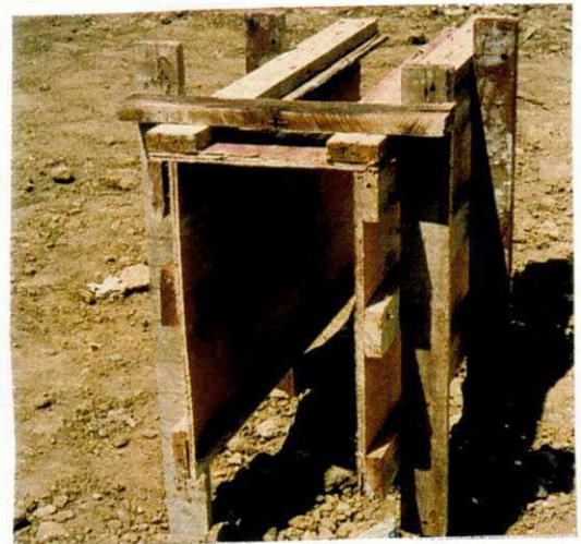
FÔRMA PARA CONCRETAGEM DA "CABEÇA" DO PILAR
