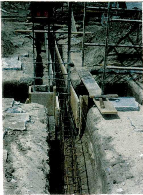
CINTAMENTO E SAPATA
