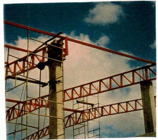
"CABEÇA" DO PILAR CONCRETADA
