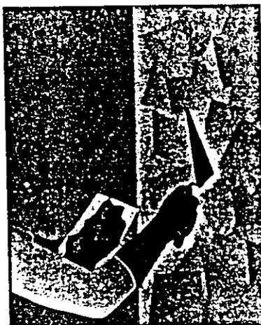
FIGURA 13 Aplicação do lado dentado da desempenadeira, formando cordões
