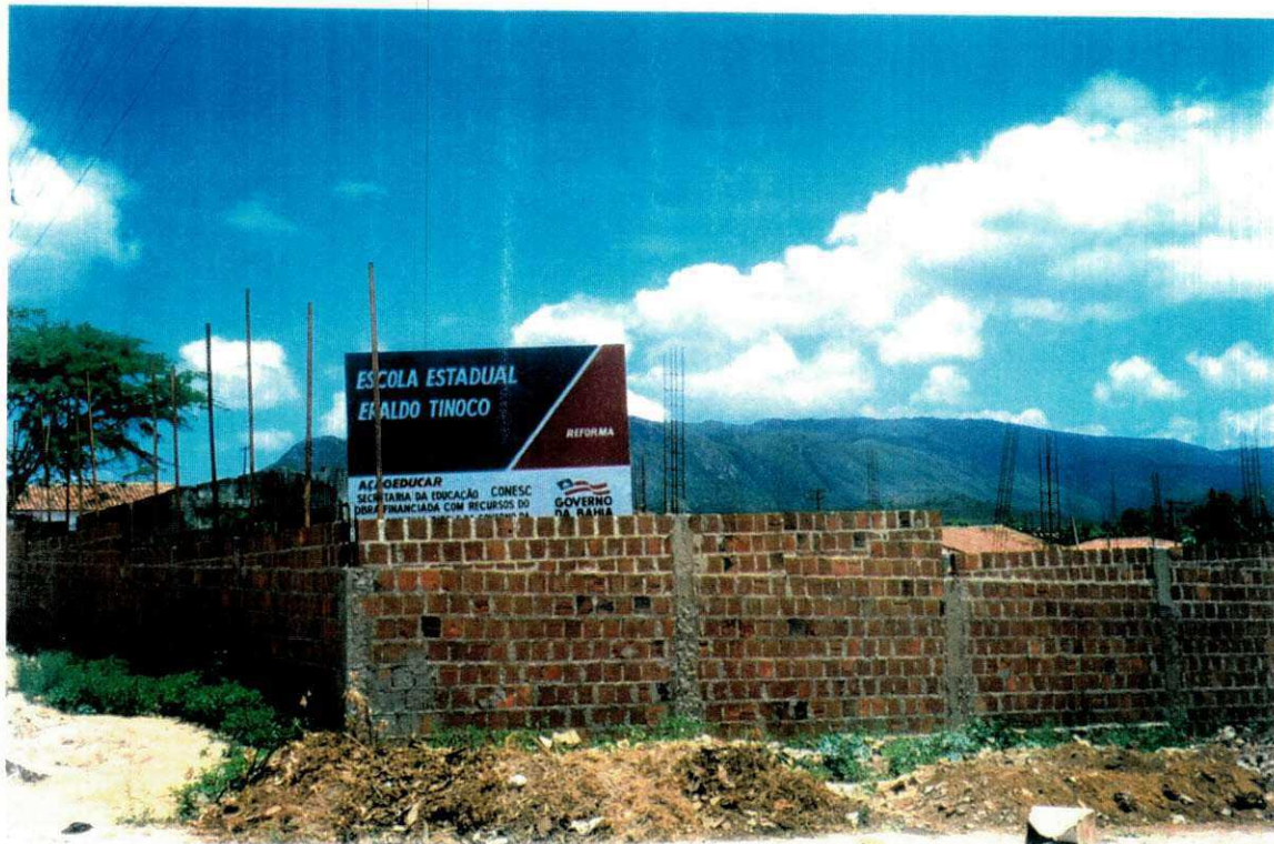
SITUAÇÃO DO ATUAL MURO
