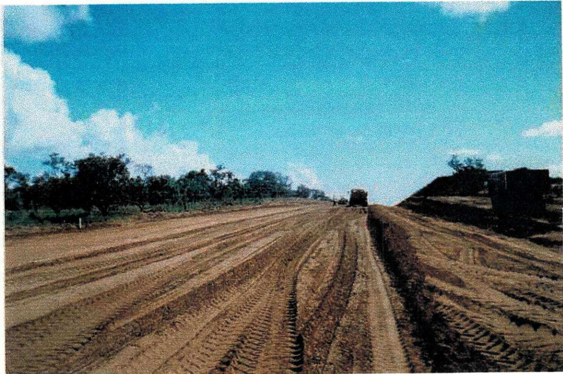
Prova de carga para verificar a existência de borrachudos.
