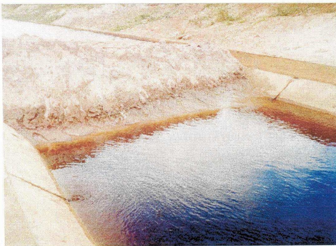
Foto 07 – Canal 01 com barramento, vendo-se a drenagem através de juntas de dilatação
