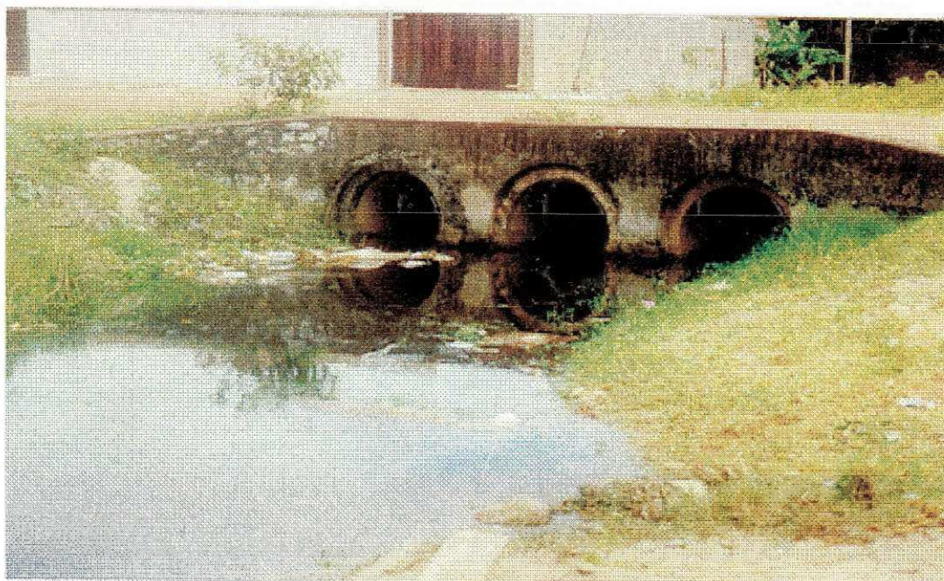
Foto 09 – Assoreamento e acúmulo de lixo no trecho entre o final do canal 03 e bueiros
