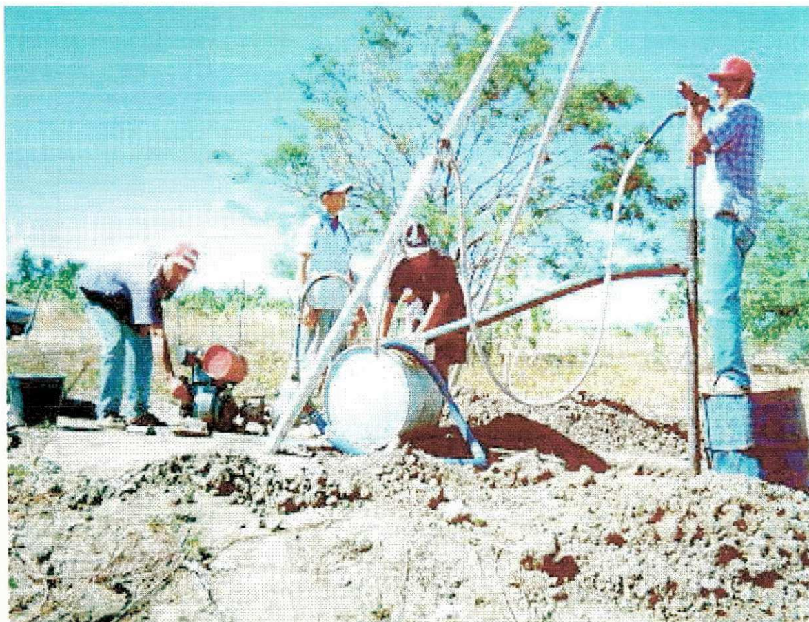
Foto 01 – Execução dos Furos de Sondagens
