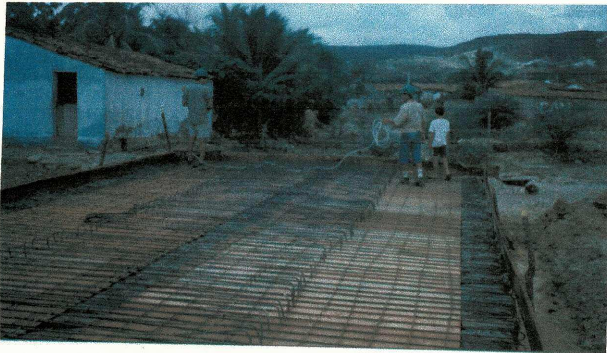
Figura 5 - PREPARAÇÃO DA FERRAGEM P/ A CONCRETAGEM
