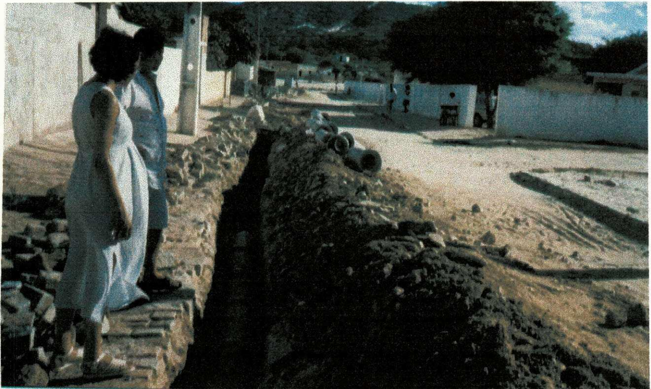
Figura 4 - ESCAVAÇÃO P/ COLOCAÇÃO DO ESGOTO
