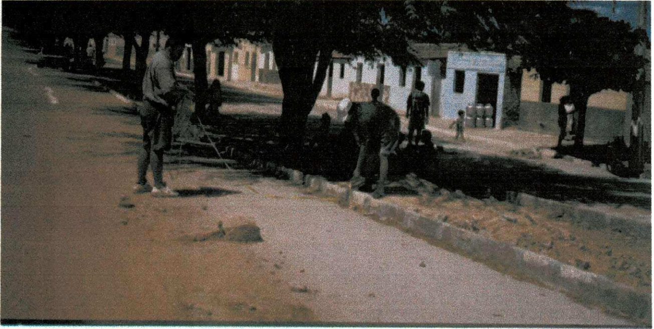
Figura 3 - MEDIÇÃO DO CALÇAMENTO
