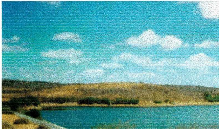
Figura 5.1 Barragem Boqueirão do Cais x Impactos Ambientais
