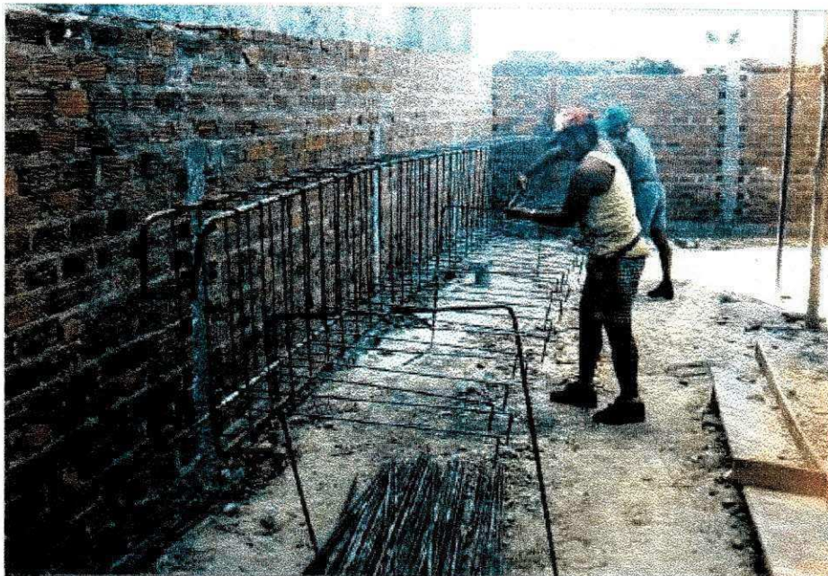
Armação de uma das vigas
