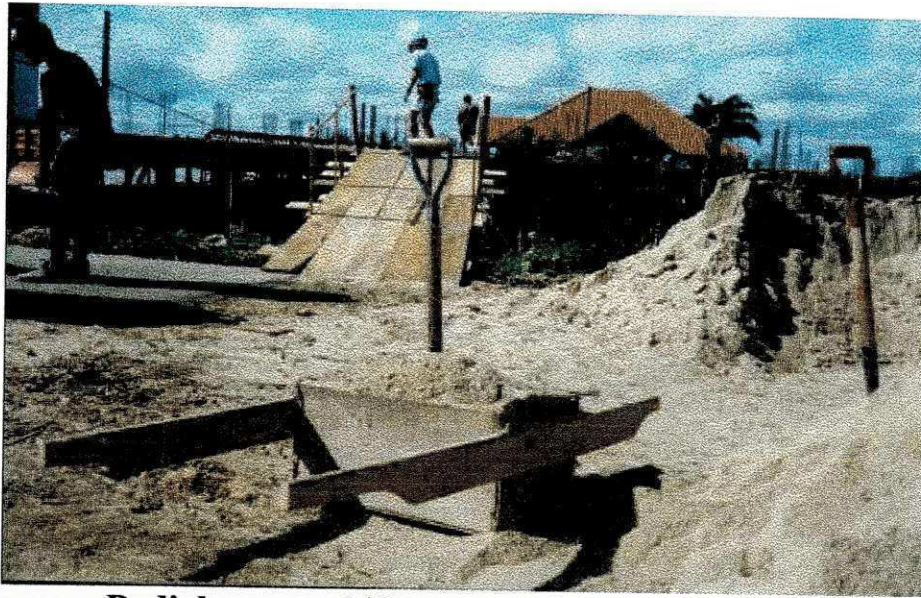
Padiola preenchida com areia para o preparo do concreto e argamassa
