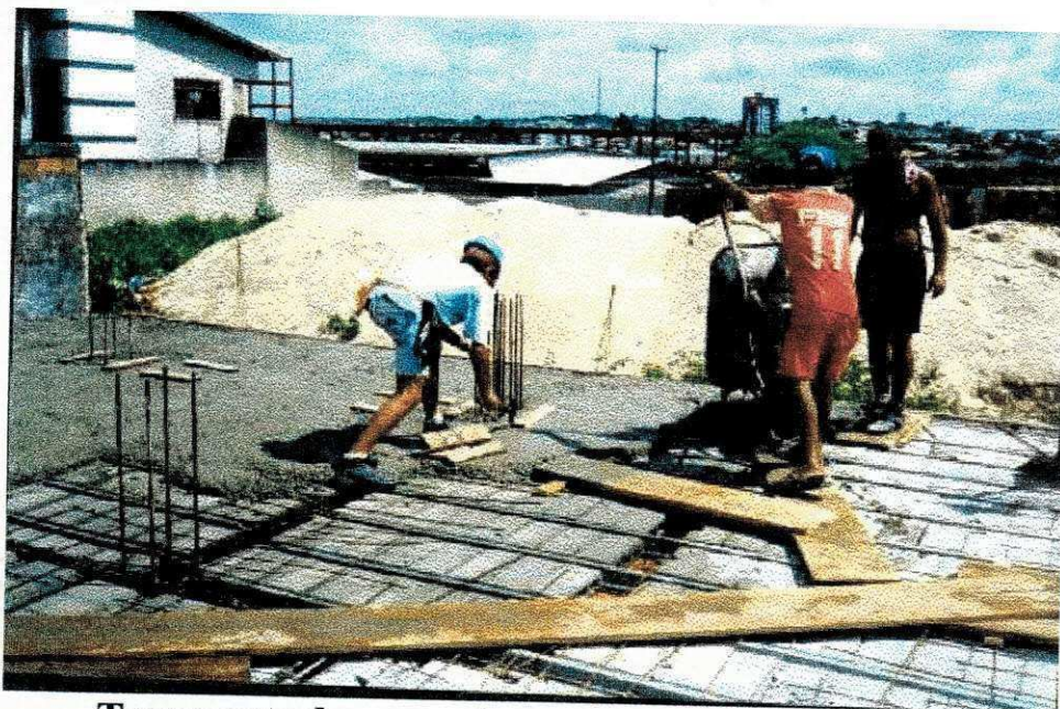
Transporte do concreto e execução do capeamento
