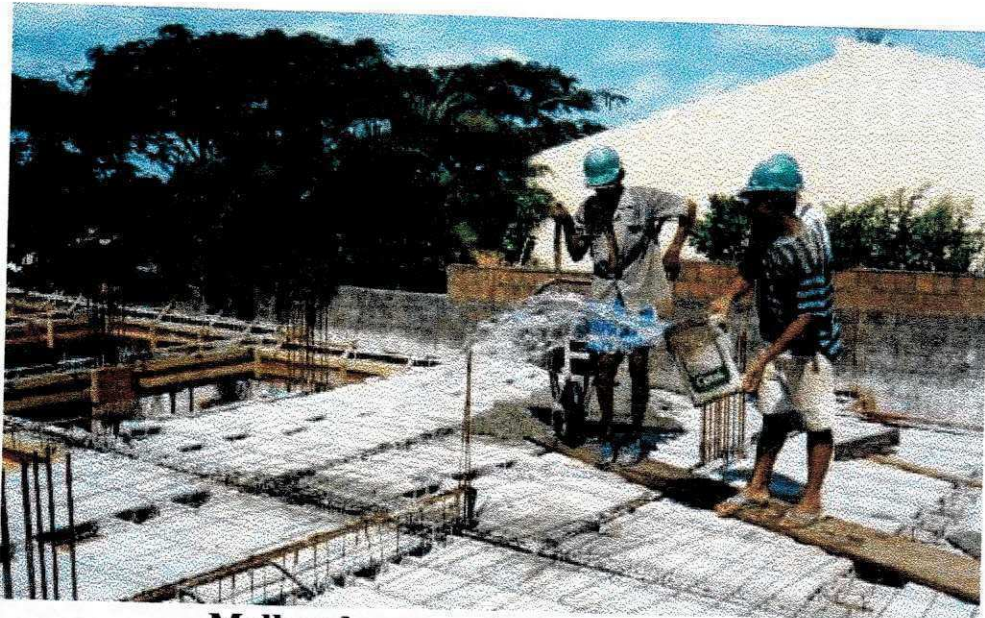
Molhando-se as vigotas e os blocos para a realização do capeamento
