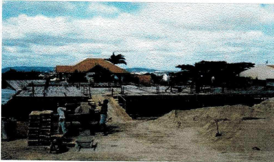
Preparo do concreto e argamassa
