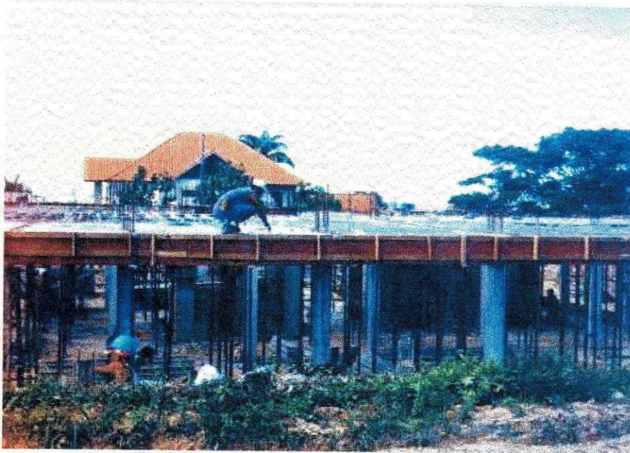
Colocando a Ferragem Negativa
