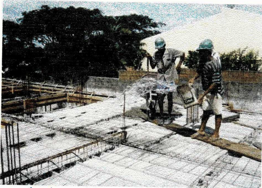
? Aguagem das vigotas e lajotas antecedendo o enchimento da laje.
