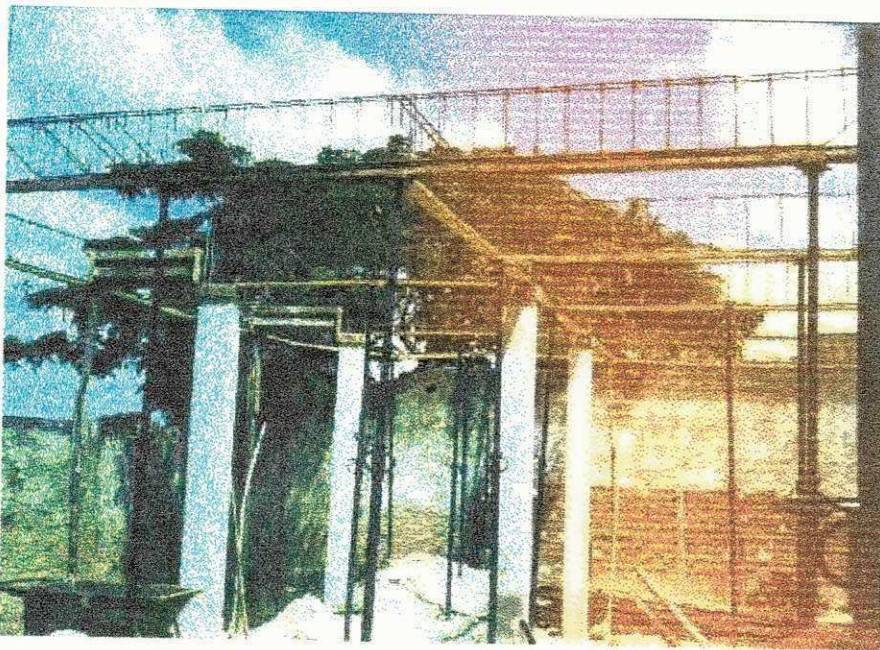
Disposição dos pilares e vigas. Note-se a presença de bacias e cavaletes e das estroncas metálicas extensíveis.
