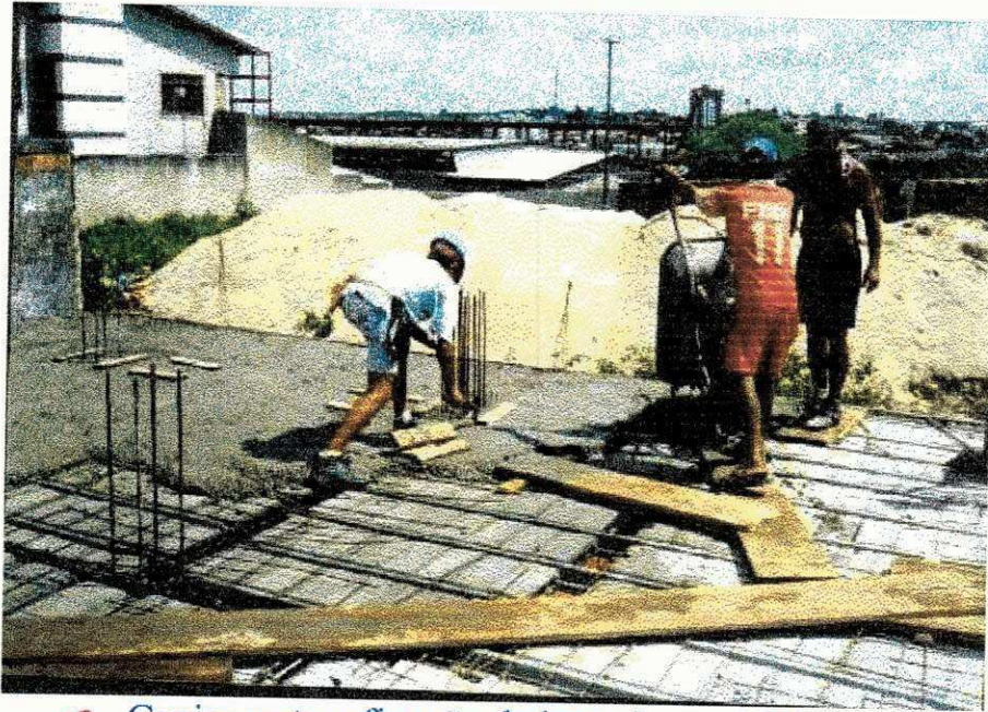
? Capiamento e fixação da base dos gualhos. ?
