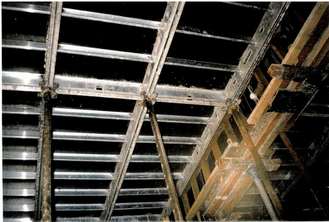
Fig. 9 - Fôrmas Metálicas e escoramento
