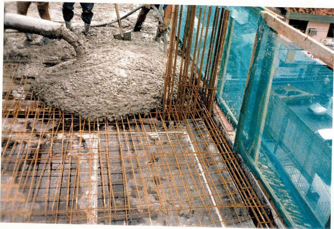
Fig. 4 - Concreto bombeado
