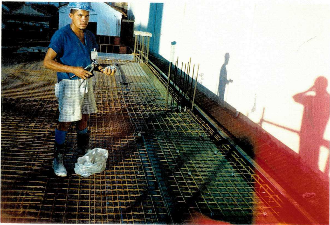
Fig. 6 - Operário colocando espaçadores (cocadas)
