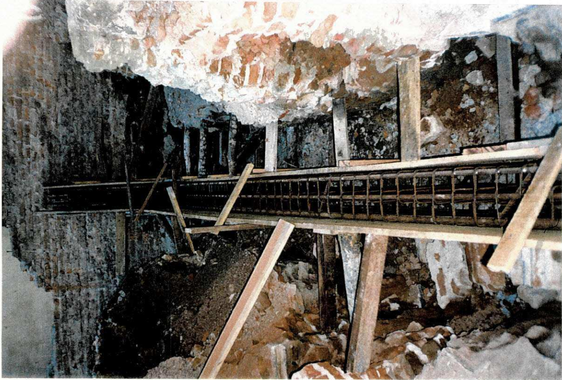
Fig. 1 - Ferragem e formas da viga de equilíbrio
