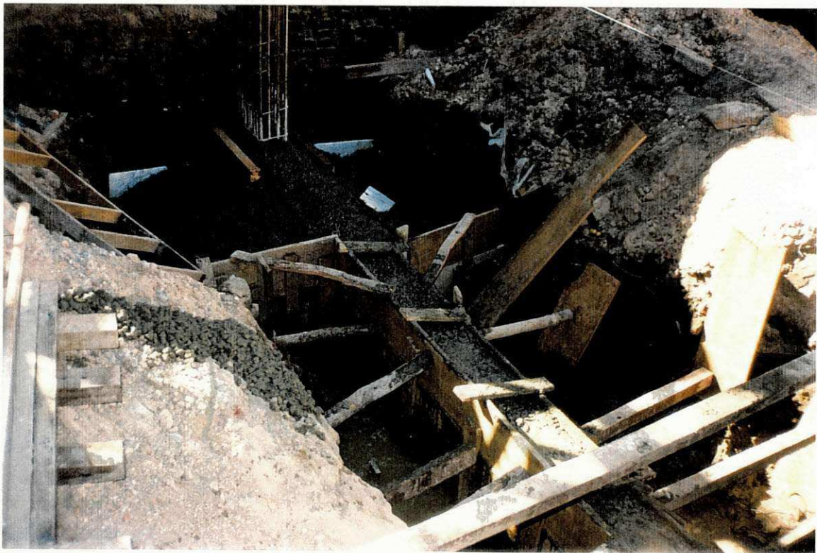
Fig. 2 - Sapata com viga de equilíbrio
