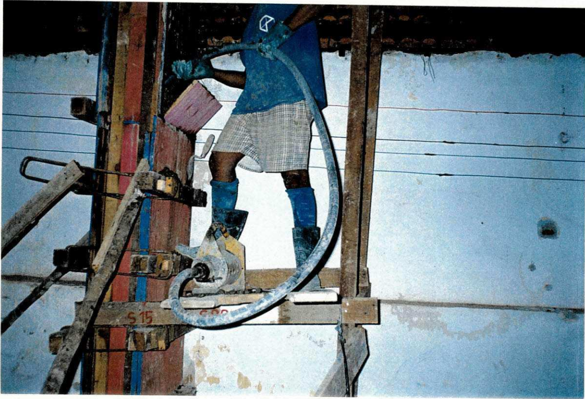
Fig. 5 - Adensamento do concreto com vibrador
