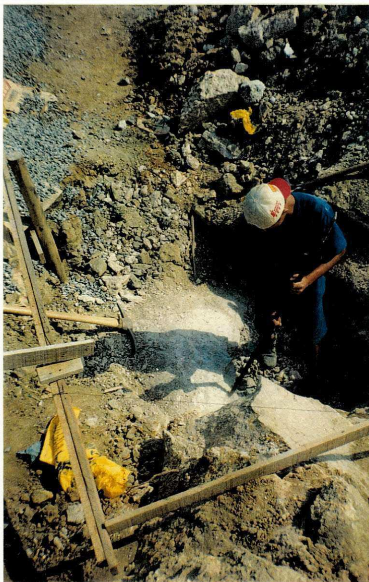
Figura 07 – Escavação manual feita na rocha aflorante.
