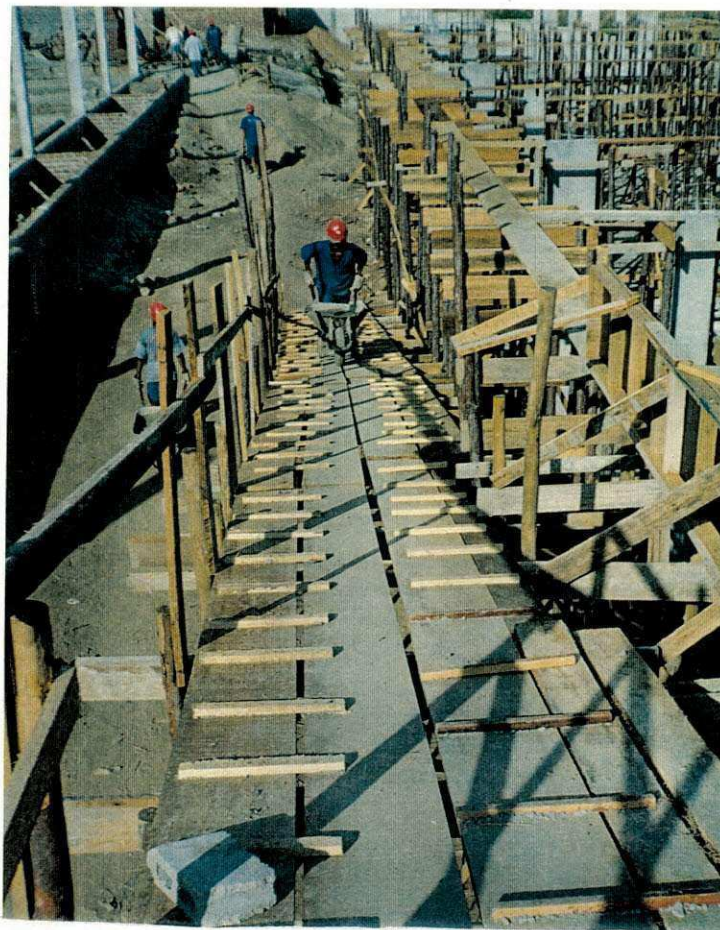
Figura 15 – Rampa de acesso à laje.
