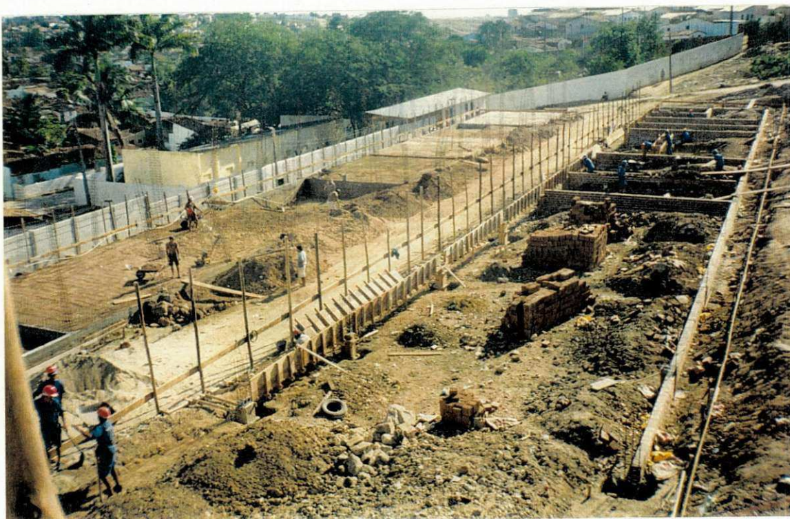
Figura 06 – Gabarito da obra.
