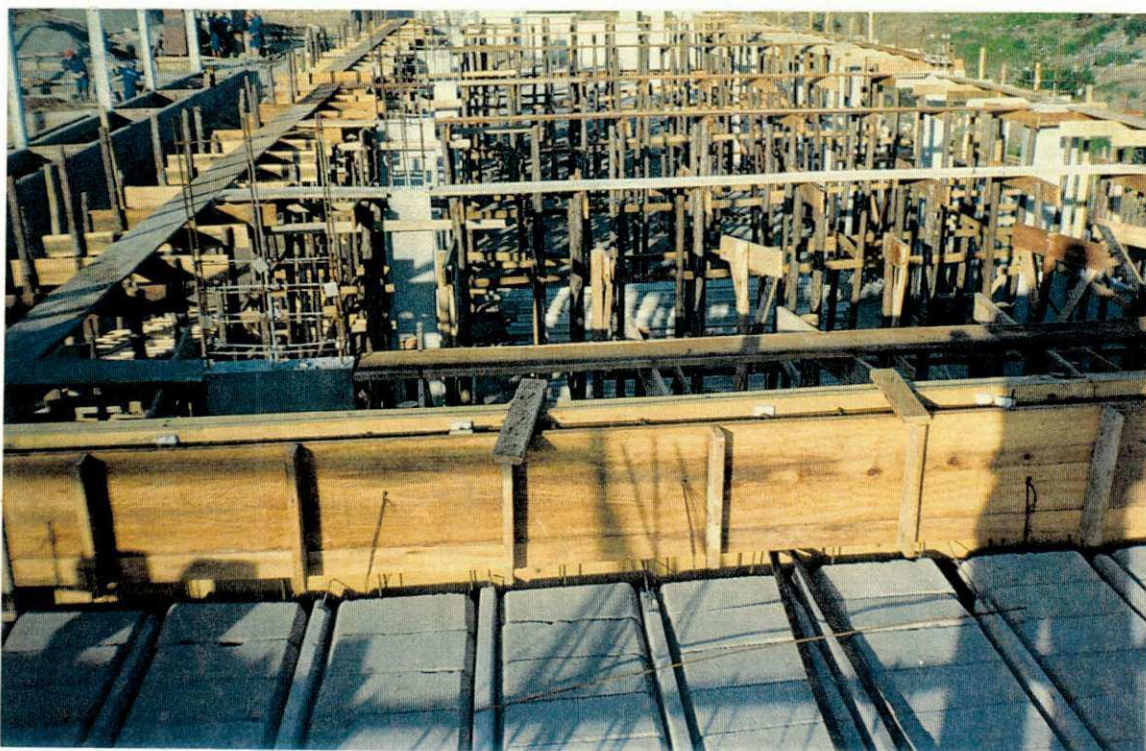
Figura 12 – Montagem de um painel de vigas para a concretagem da laje
