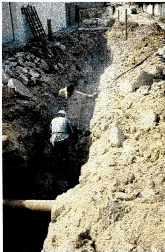
Fig. 01(Escavação em Rocha)
