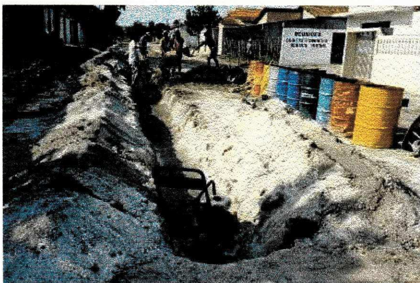
Fig. 03 (Reaterro da Vala)
