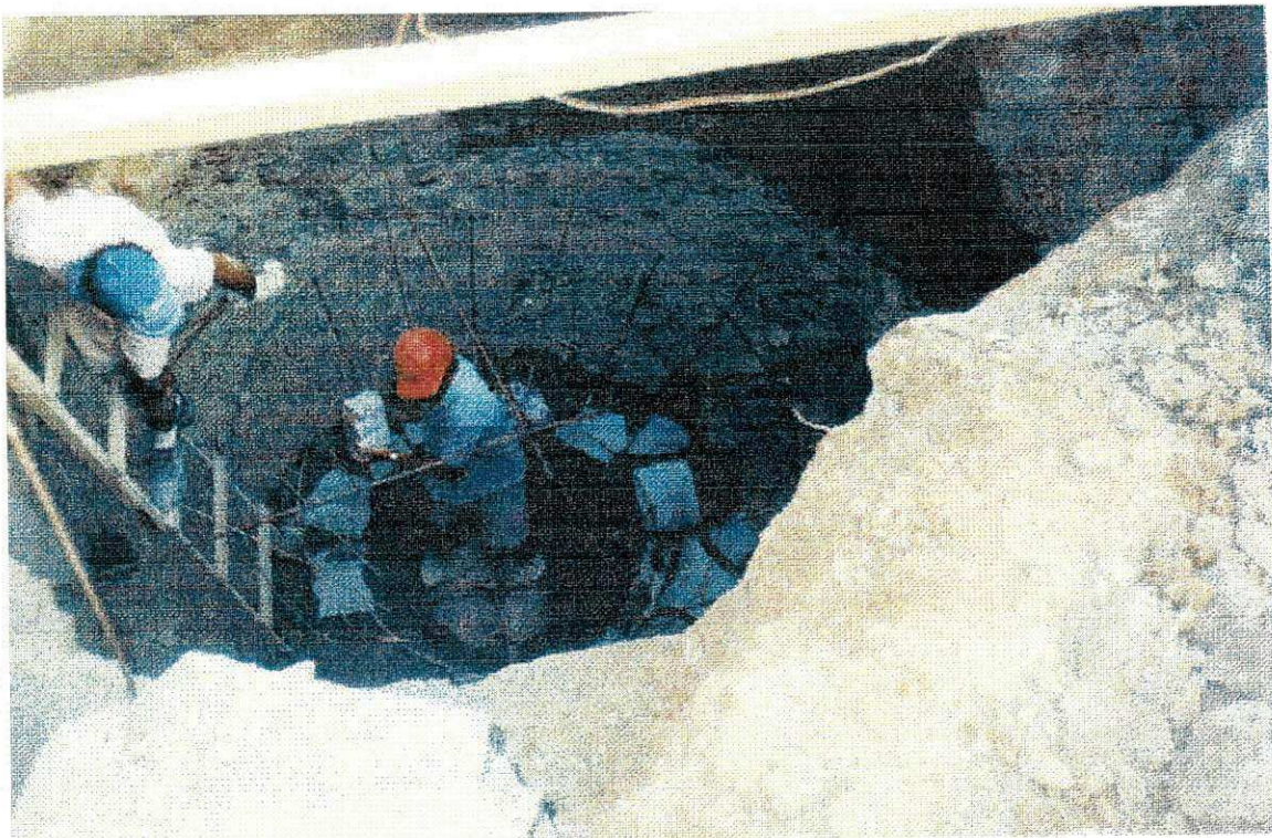
Foto 05 - Colocação do gabarito metálico no poço de tratamento d'água
