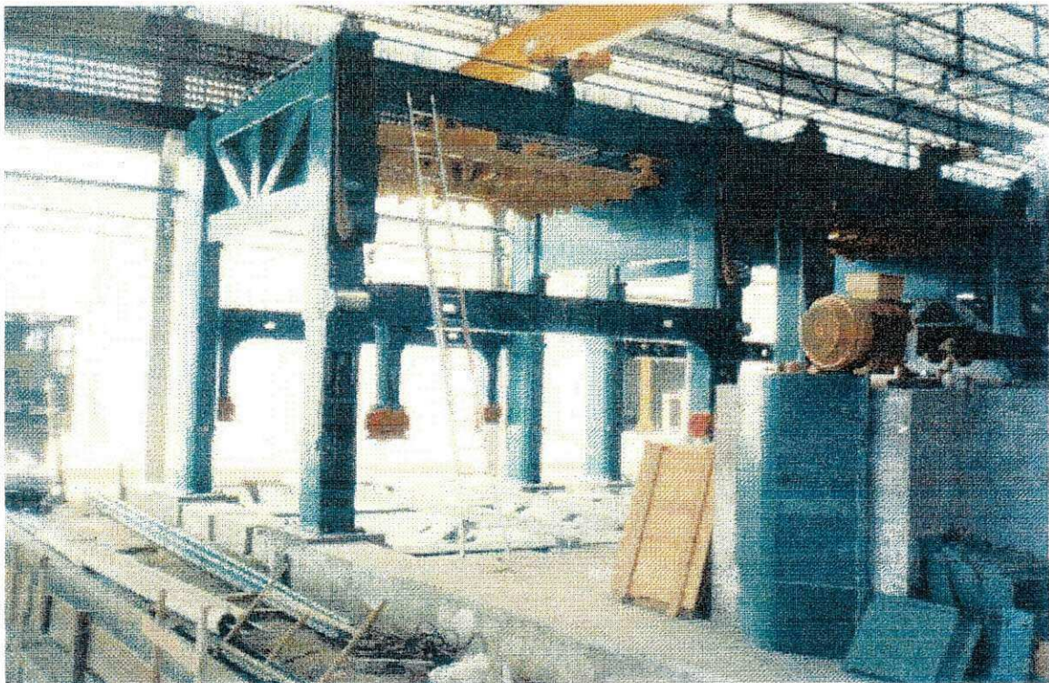
Foto 04 - Vista geral dos pilares metálicos do tear
