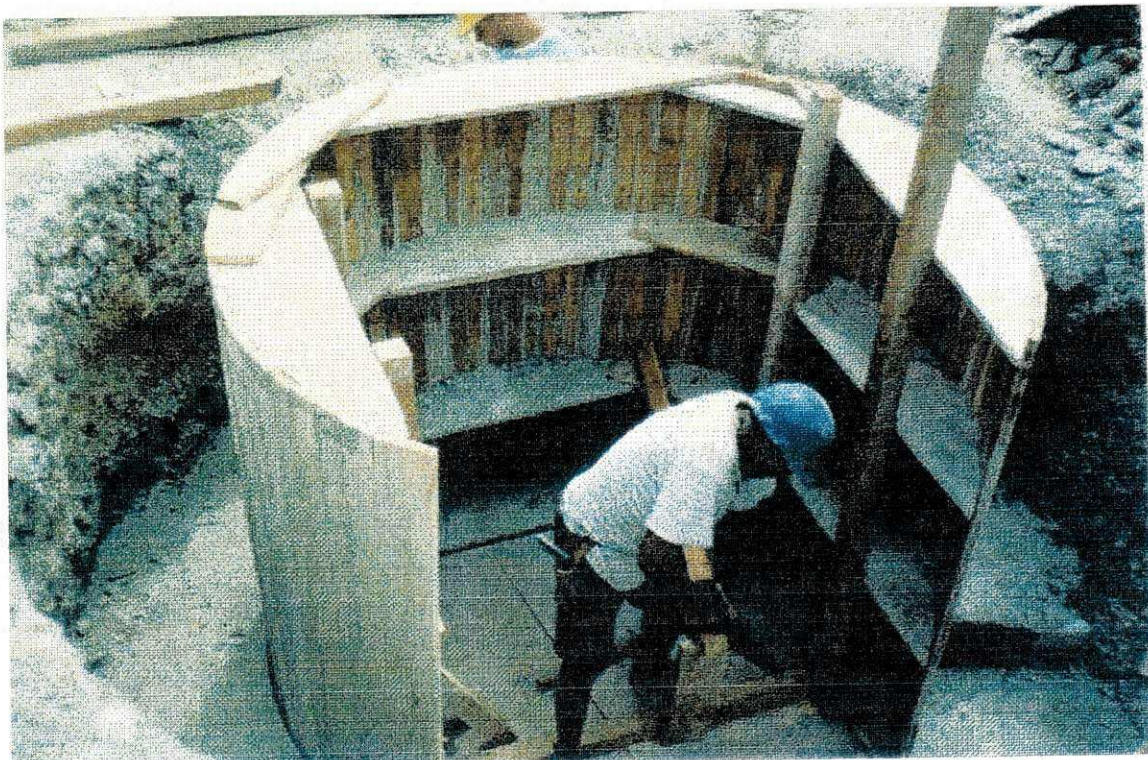
Foto 06 - Colocação da forma para concretagem das paredes do poço
