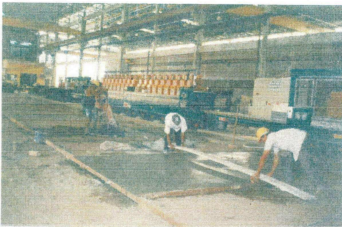
Foto 01-Construção do piso da fábrica
