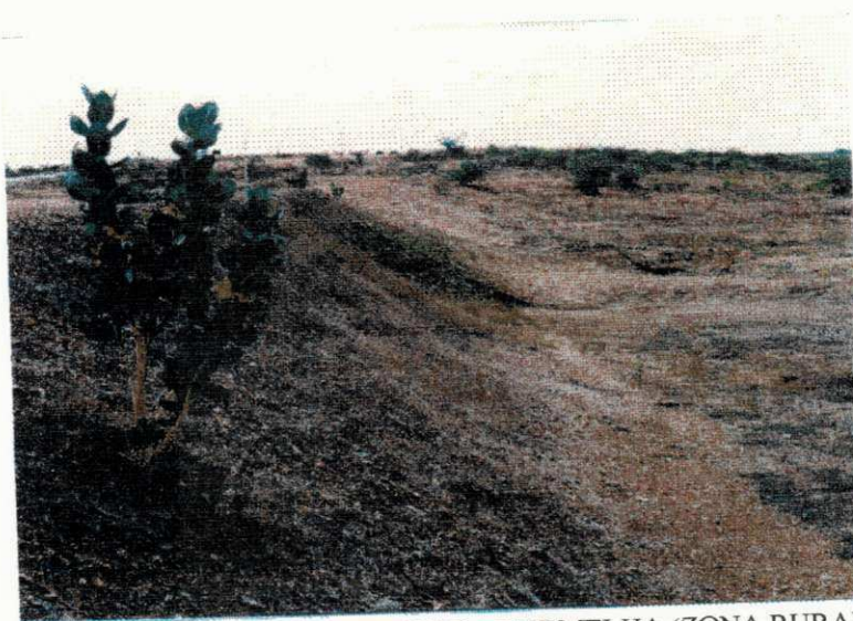
BARRAGEM PÚBLICA MALHADA VERMELHA (ZONA RURAL)
