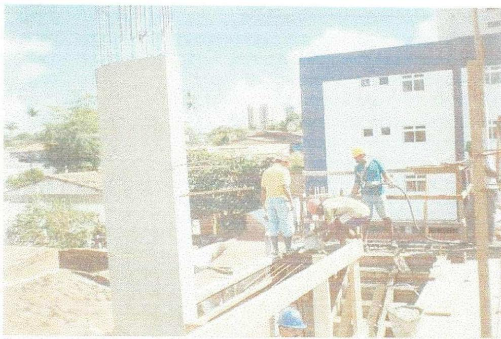
Fig 6 – Vibração do concreto
