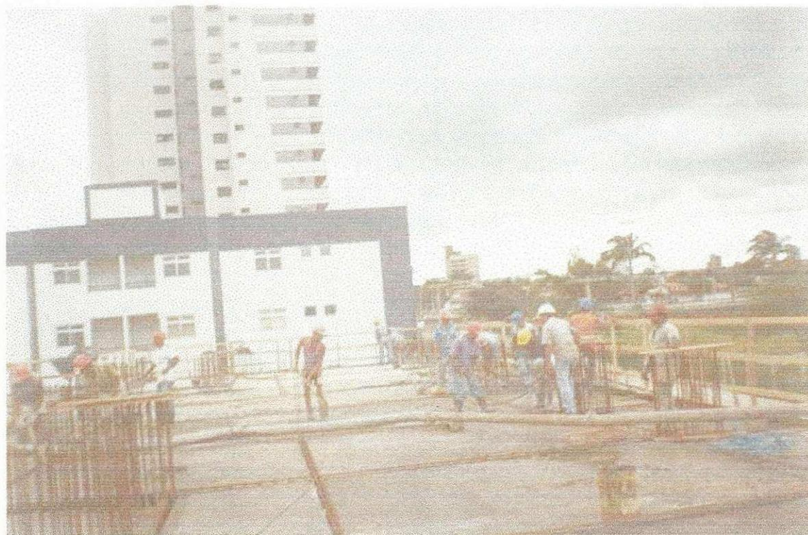
Fig.5 – Lançamento de concreto
