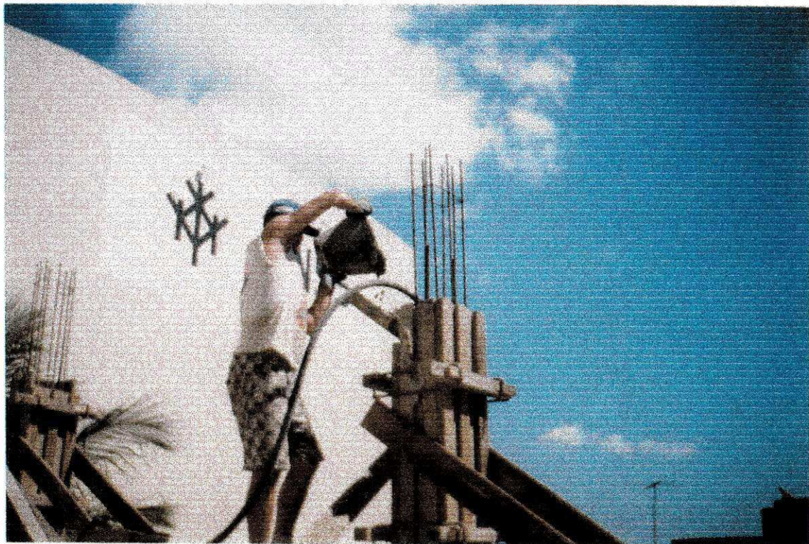
Foto 4 – Lancamento e adensamento do concreto.
