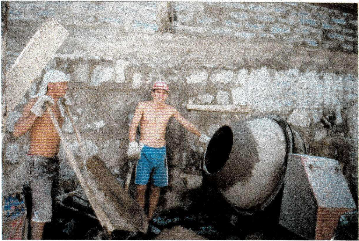
Foto 3 – Preparo da argamassa e do concreto.
