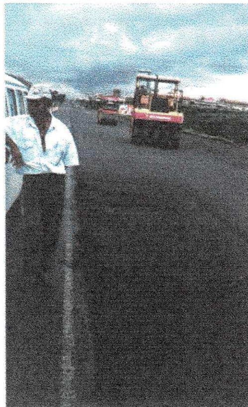
Figura 7: camada betuminosa com 7cm de espessura.
