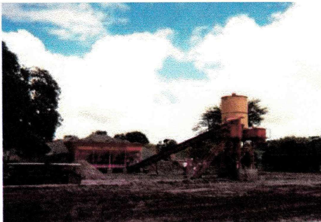
Figura 3: Usina de Mistura
