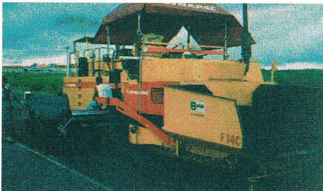
Figura 8 – Acabadora utilizada na BR 230
