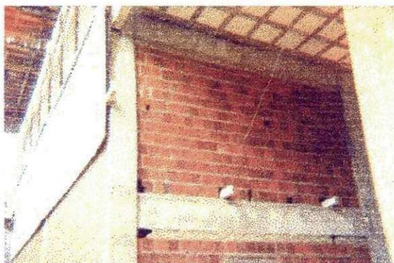
Fig. 01- alvenaria com seu encunhamento
