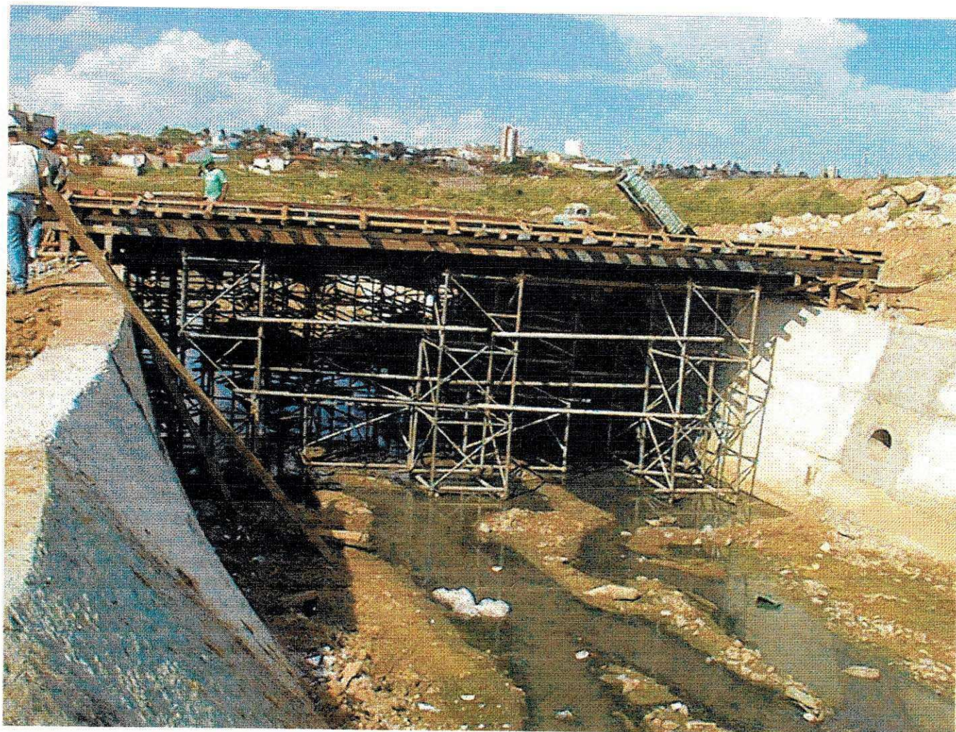
Imagem 08 - Vista da ponte e o escoramento metálico
