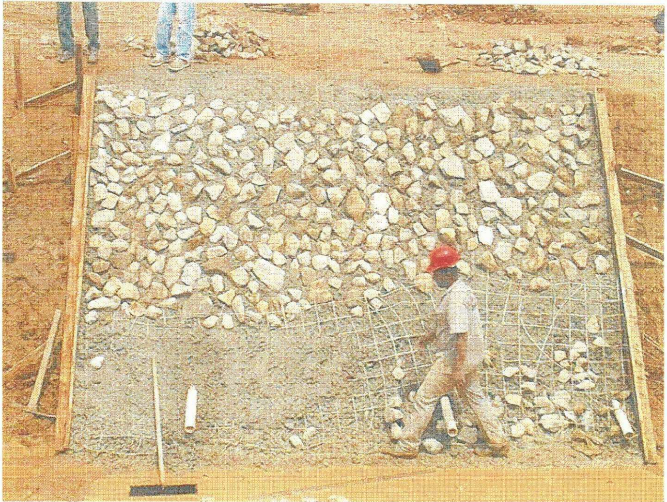
Imagem 05 - Execução dos taludes do canal
