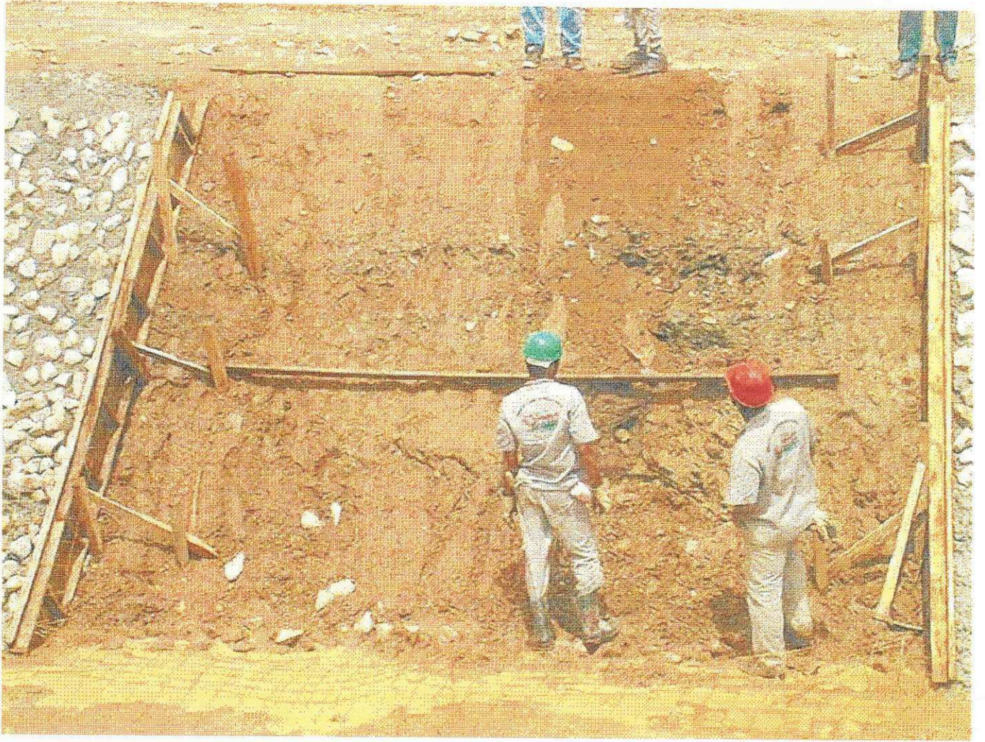
Imagem 06 - Execução dos taludes do canal
