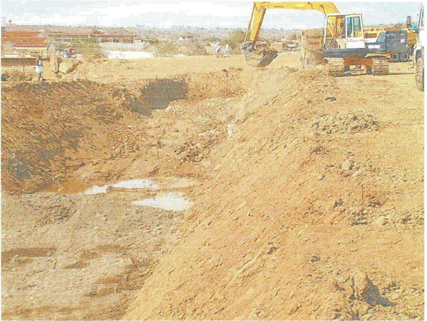
Imagem 04 - Escavação dos taludes
