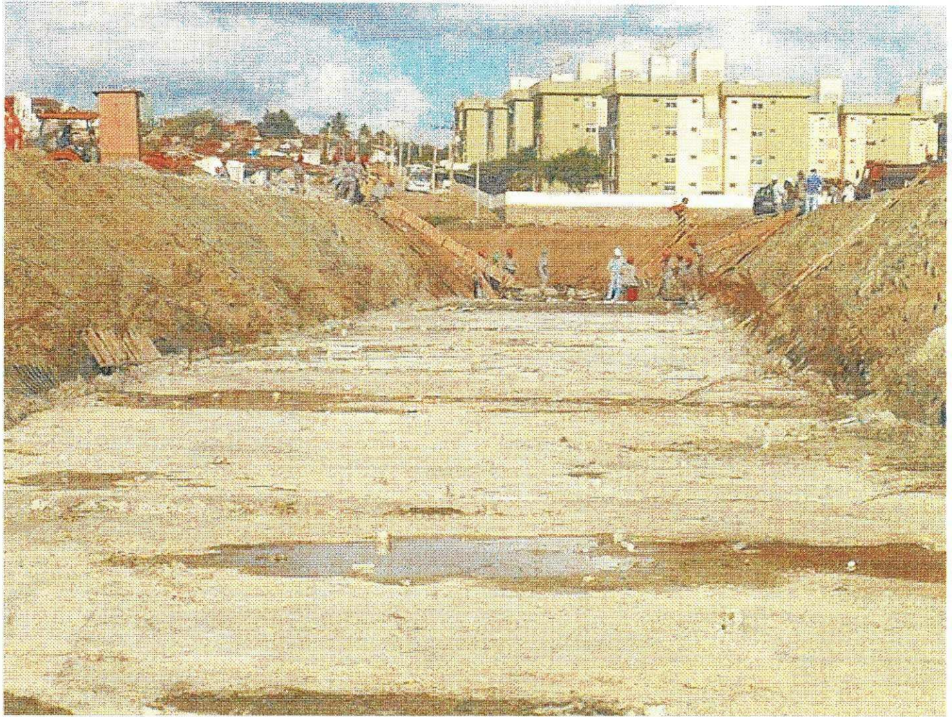
Imagem 02 - Vista do piso do canal já concretado
