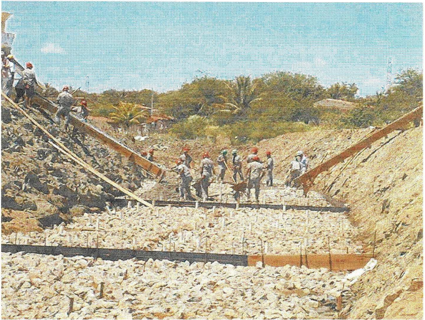
Imagem 01 - Concretagem do fundo do canal
