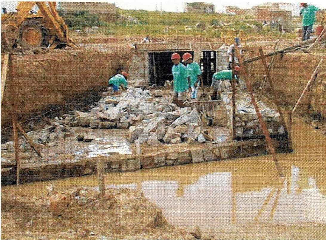
Imagem 10 - Execução do sub - canal
