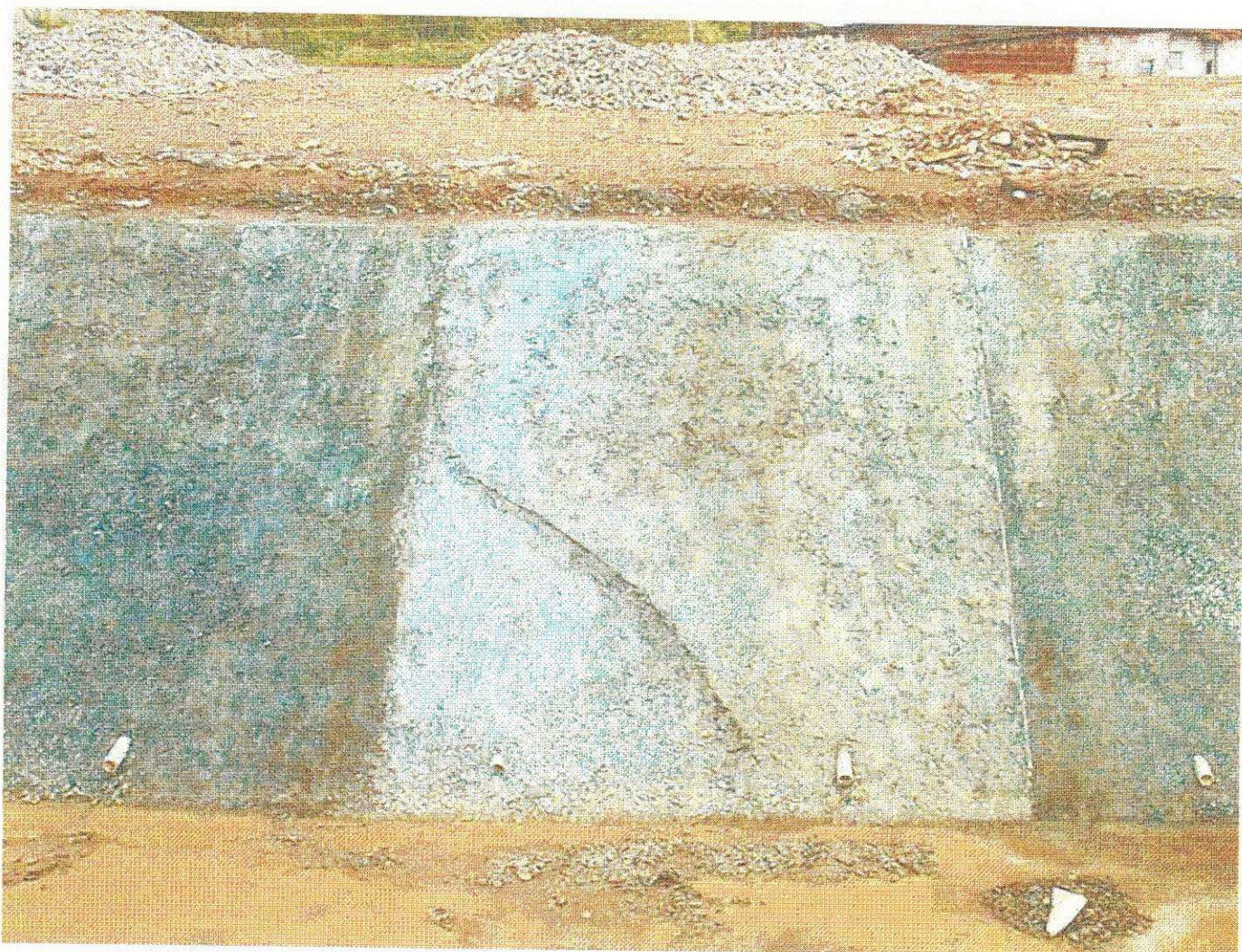
Imagem 07 - taludes do canal já concretados
